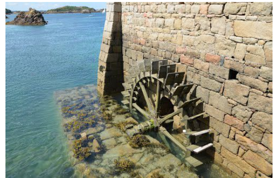
Figura 2.6 Turbina en la isla de Bréhat, Bretaña, Francia (tomado de Google Earth)
