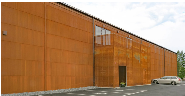
Kuva 16. CorTen-paneeli julkisivussa. Ruukki Oy.
