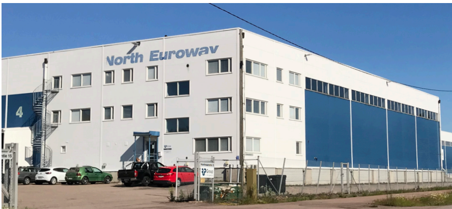
Kuva 19. Hallin toimisto-osanpuoleinen julkisivu ennen saneerausta. Erkomat Oy
