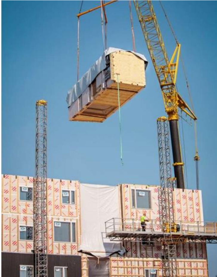
Kuva 9. Esivalmistettujen tilaelementtien käyttö työmaalla. (Luento: Puukerrostalot, 24.1.2023)
