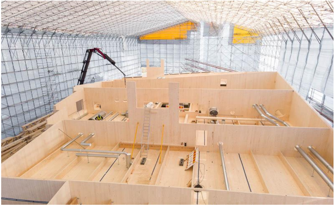
Kuva 15. Hopealaakson päiväkodin rakennusvaihe, jossa runkoa rakennetaan CLT-massiivipuulementeistä (Puurakentajat Group Oy, 2023).
