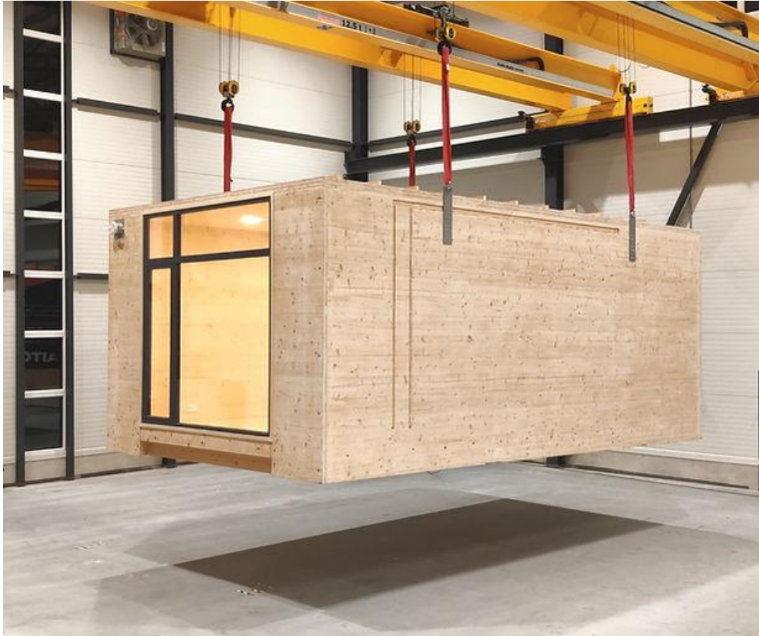
Kuva 6. Kokonainen CLT:stä tehty tilaelementti (Aitopuu Suomi Oy, 2023).
