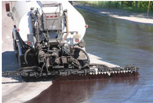
Fig. 5. Suministro e Instalación de emulsión asfáltica
