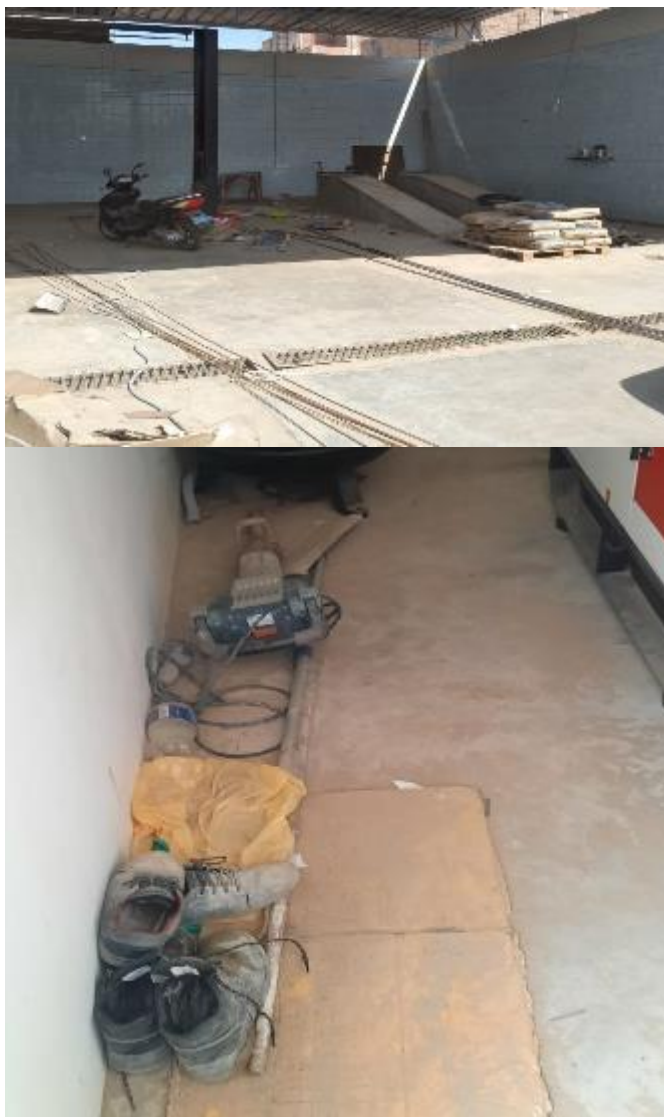
Figura 38. Estado inicial de la limpieza en la estación de servicios Vela
