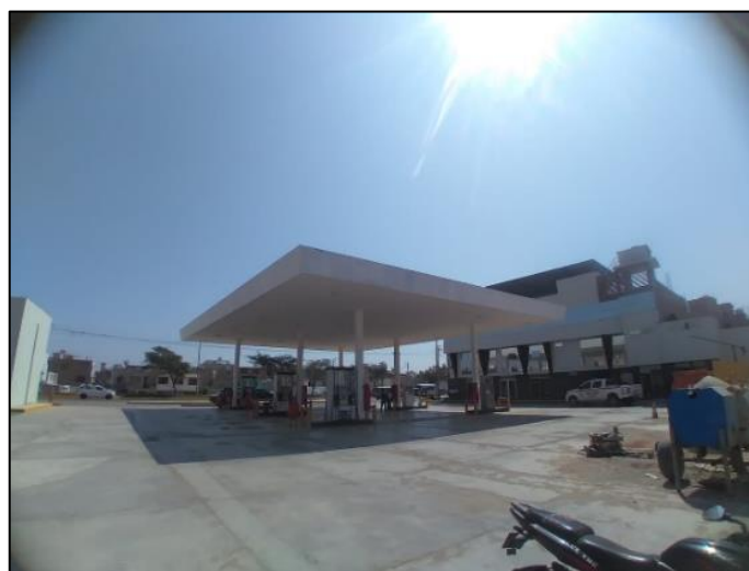
Figura 6. Estación de servicios Vela
