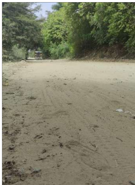
Figura 1. Vía no pavimentada al AA. HH La Morana
