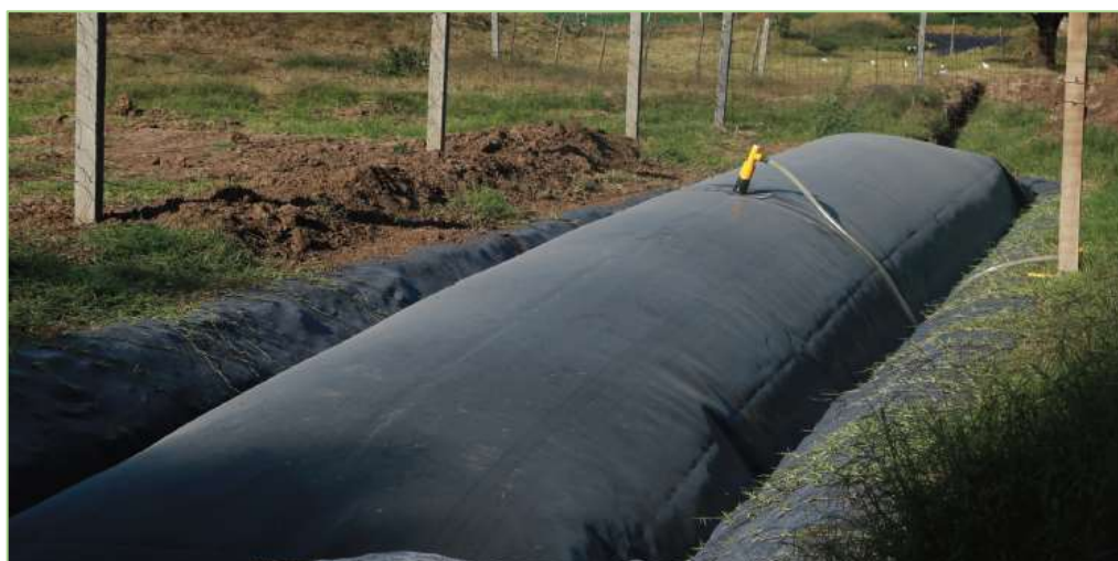
Figura 31. Biodigestor tipo biobolsa
