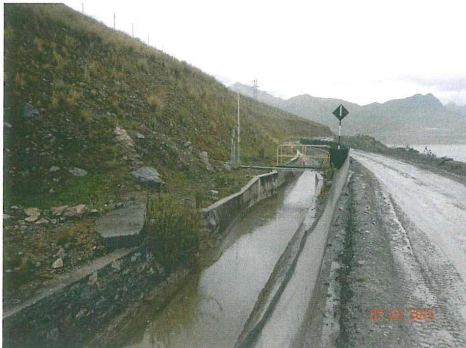
Fotografía N° 14: Punto de monitoreo N° 16, afluente canalizado proveniente de la quebrada Huincush
