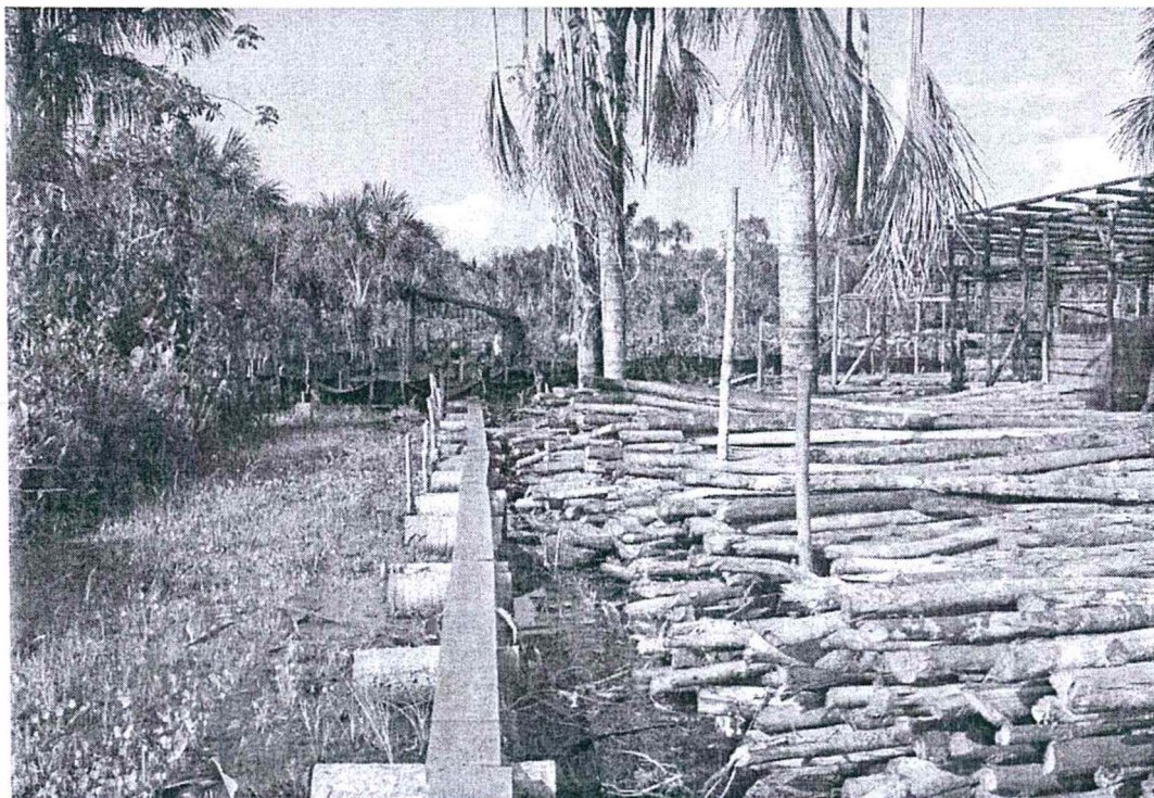
Inicio del recorrido aproximadamente desde la tubería del Km 7 al Km 8+100, del Derecho de vía (Dvd) de Saramuro a Batería 3
