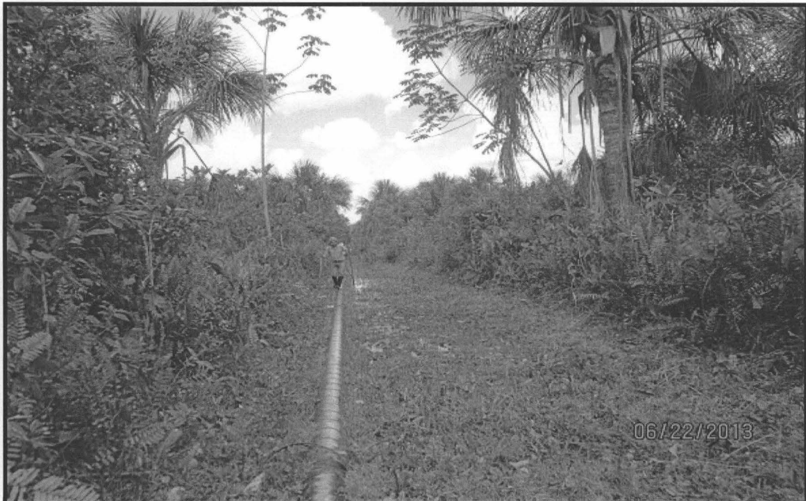
Recorrido por el ducto de transporte de crudo, a través de la zona pantanosa, partiendo del km 16, hacia el km 7 +726m, donde se reportó el primer incidente de corte.
