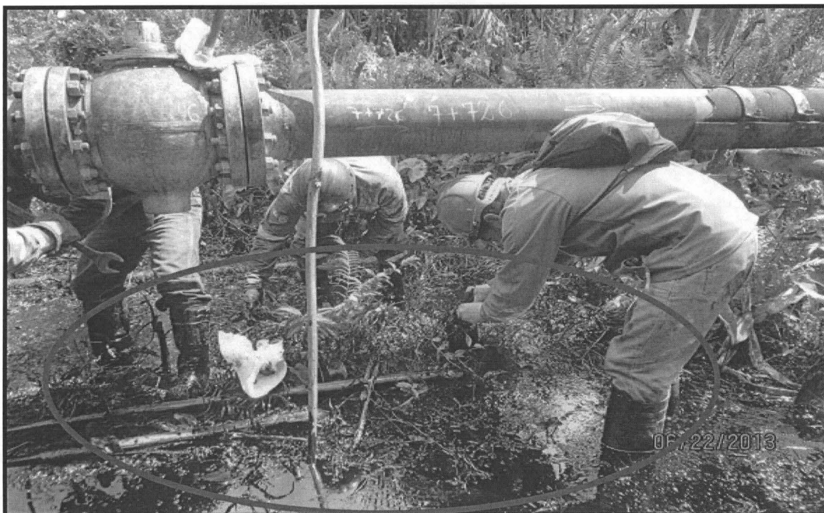
Constatación del derrame del crudo, se observa el crudo a nivel superficial y la colocación de grapas, en este punto se recolecto muestra de sedimento.
