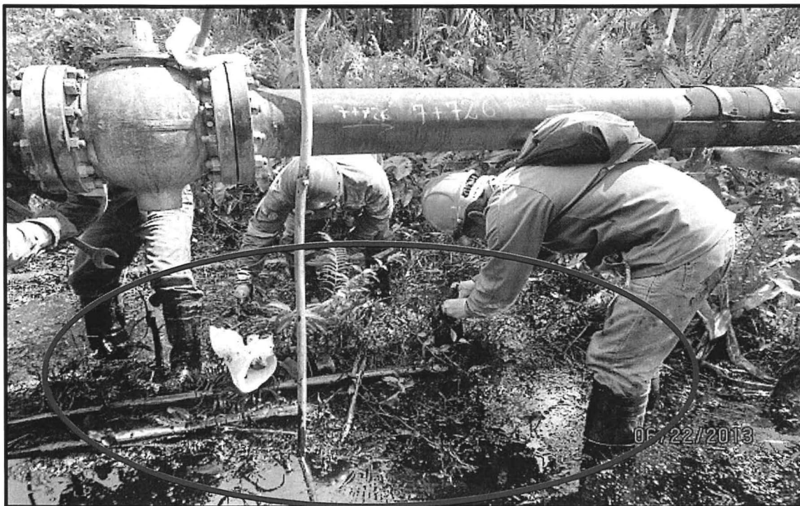
FOTOGRAFÍA 03: TOMA DE MUESTRA DEL CORTE Km 7+ 726
