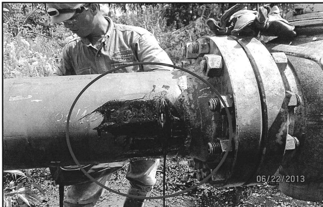
FOTOGRAFÍA 04: CORTE DE LA TUBERIA Km. 7+ 726
