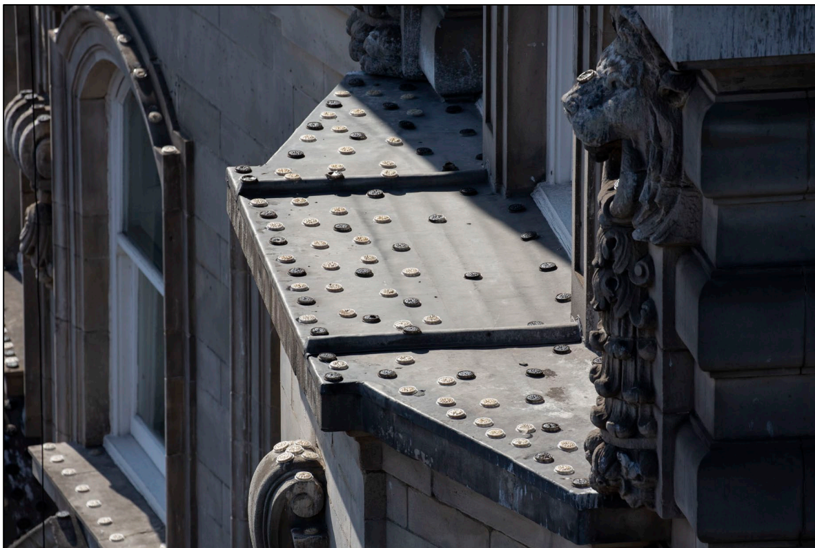
Vedlegg 3. «Fire-gel» eller «Bird Free» som er plassert på bygninger slik at krykkjene ikke kan hekke der. Newcastle mai 2019. Foto: Karl-Otto Jacobsen©.
