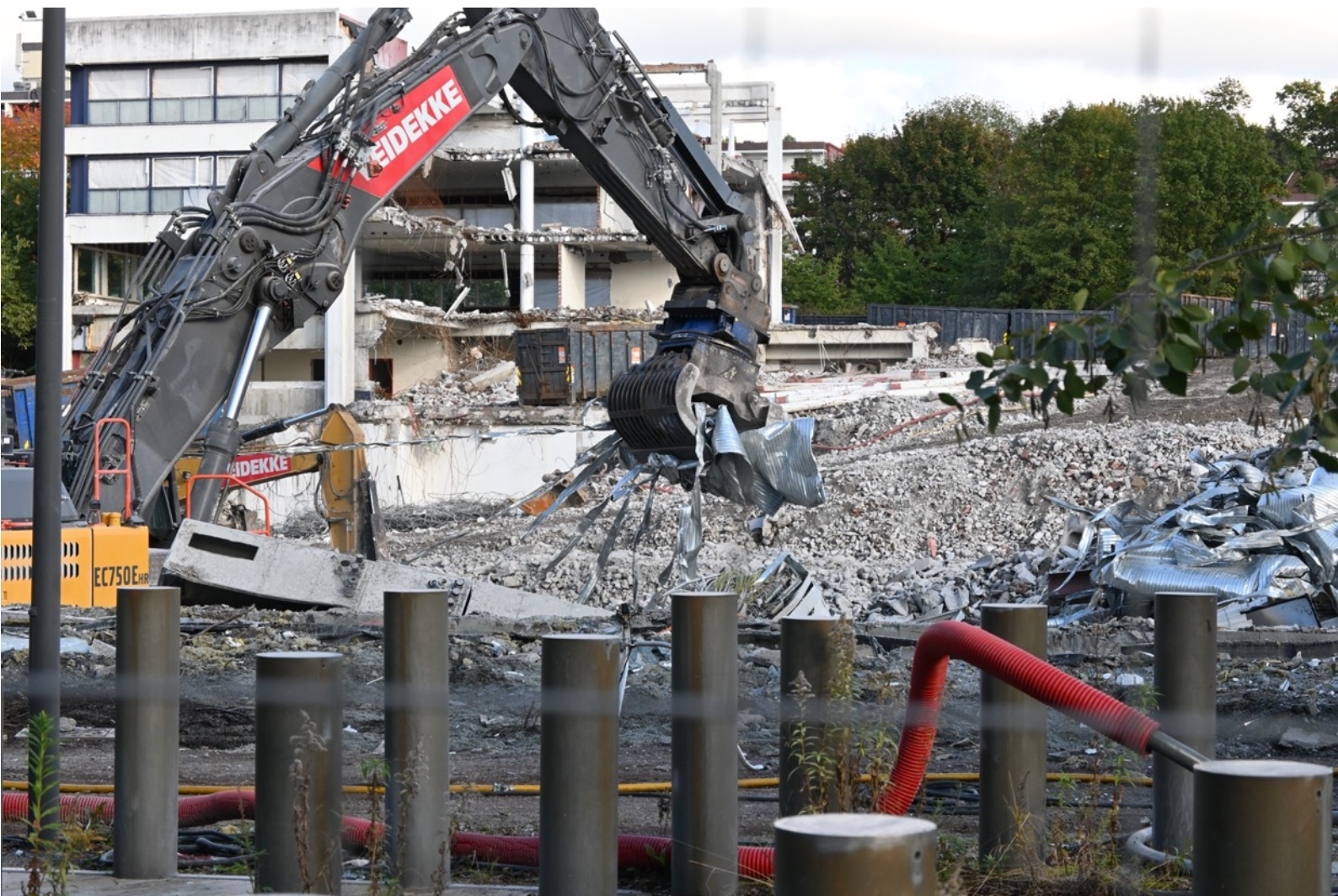
Bilde 11: Byggeplass på Skøyen under riving av eksisterende næringsbygg. Nye boliger skal bygges, 2022.
