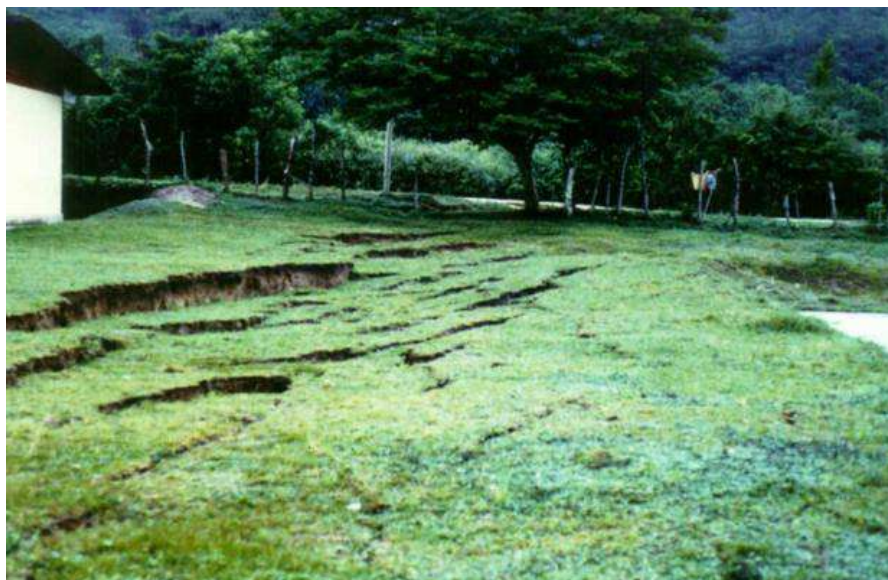
Figura 2.14 Agrietamiento del terreno por licuación en Moyobamba (1991)
