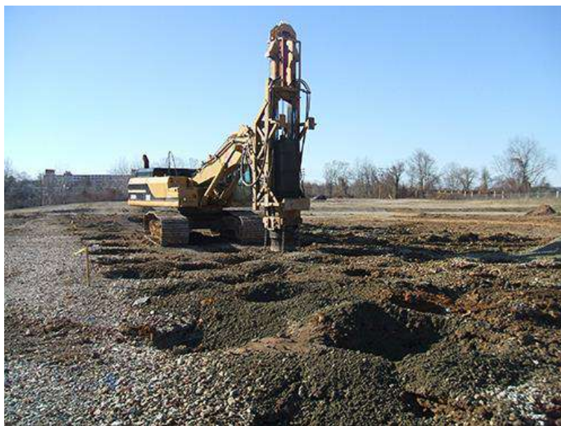
Figura 6.4 Aplicación de Compactación Dinámica Rápida
