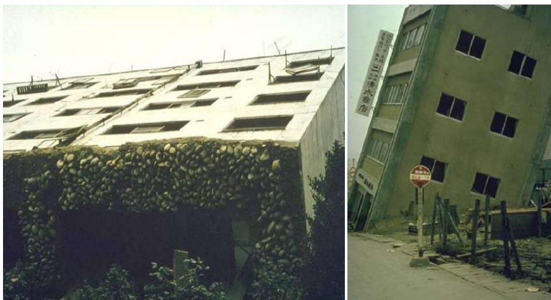
Figura 2.26 Perdida de capacidad portante en edificios durante el terremoto de Niigata, 1964
