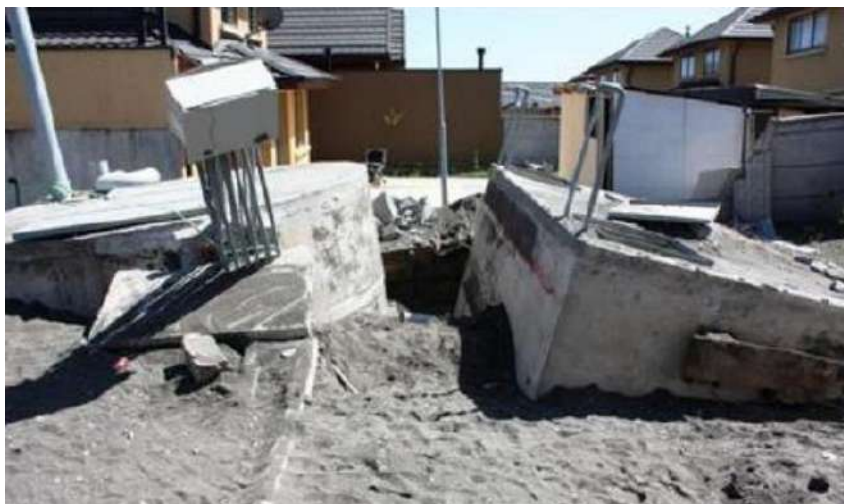
Figura 2.27 Flotación de tanques de agua en el terremoto de Chile en 2010
