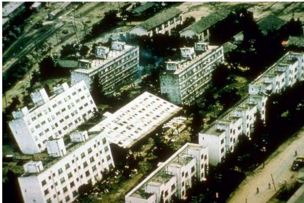
Figura 2.10 Falla de carga inducida por licuación en Niigata (1964)
