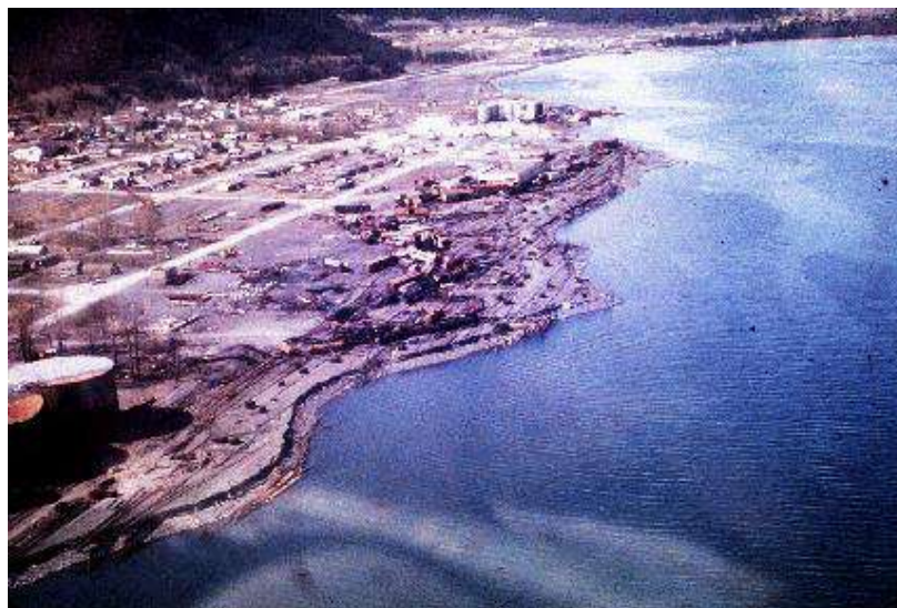
Figura 2.11 Deslizamientos de tierra por licuación en Alaska (1964)
