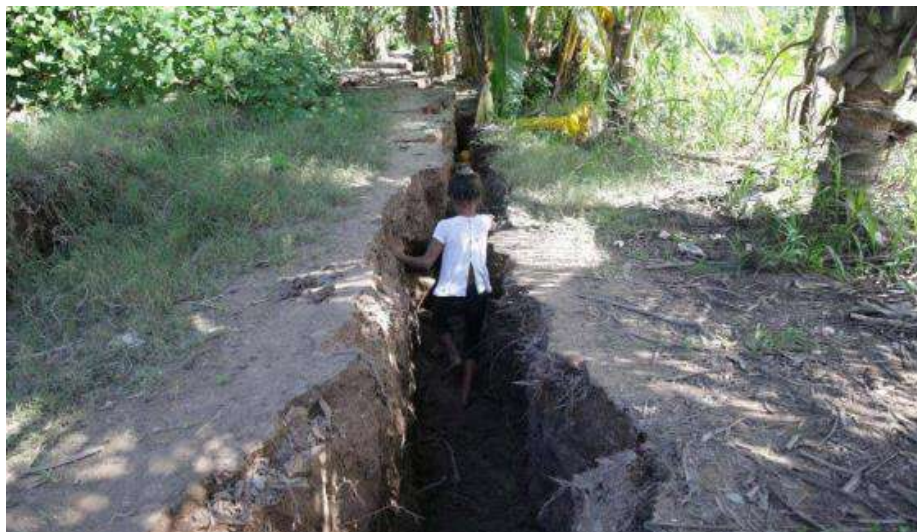
Figura 2.16 Agrietamiento de terreno en Alto Amazonas, Loreto, 2019
