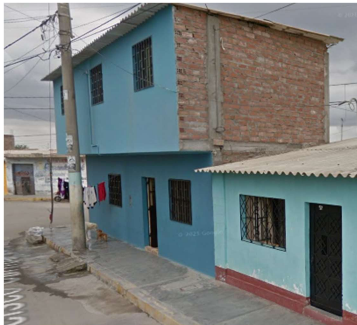
Figura 5. 1-2 Vivienda de albañilería confinada ubicada en la calle Francisco Carhuajulca VII.
