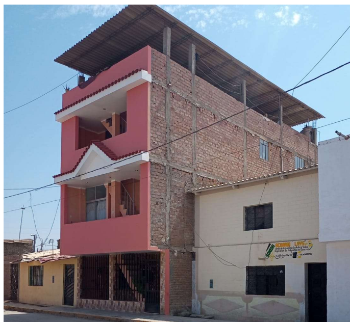
Figura 5.3-6 Edificación de 3 niveles más azotea, localizada en la Av. Alto Cayaltí, manzana 42 lote 09, con incremento de masa en los niveles Superiores.
