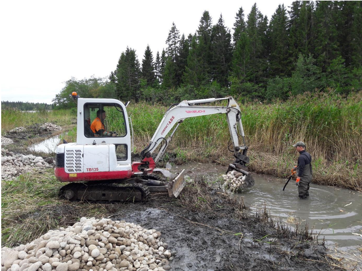
Kuva 3. Backfladan uoman kunnostusta elokuussa 2019. Kuva: Sanna Kuningas, Luke.
