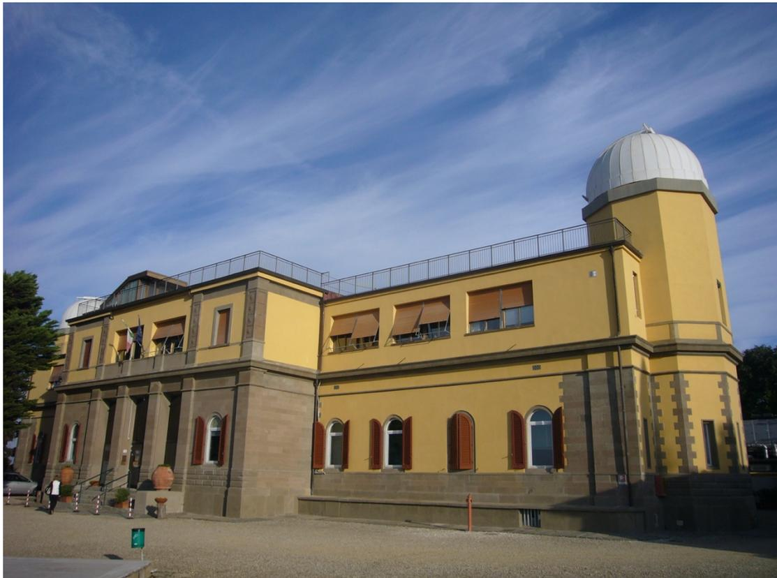
**Fig. 8** L'Osservatorio Astrofisico di Arcetri oggi. Con i lavori iniziati alla fine degli anni '50 del XX secolo, l'edificio è stato innalzato di un piano in corrispondenza delle due terrazze laterali, e la cupola centrale è stata rimossa.
