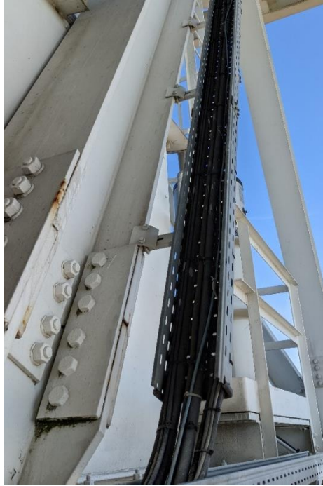
Figura 3 Canala portacavi a Medicina
