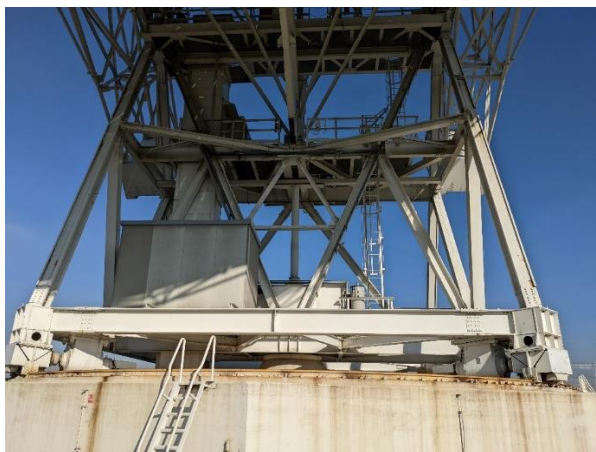
Figura 1 Posizionamento del fabbricato A.E.R. a Medicina (BO)
