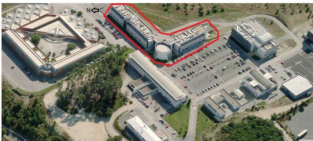
Figura 4.1: Localização do Edifício D do campus 2 [2] .
