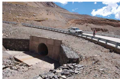
Figura 33. Obra de drenaje transversal "Paraje Ojos de Agua".
