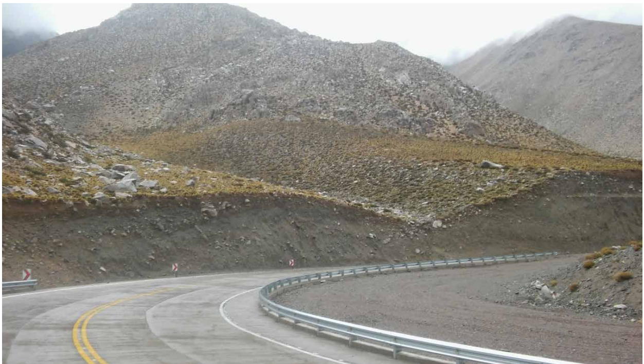
Figura 28. Cortes artificiales de otros abanicos aluviales. Al igual que el caso anterior la pendiente generada es inestable.
