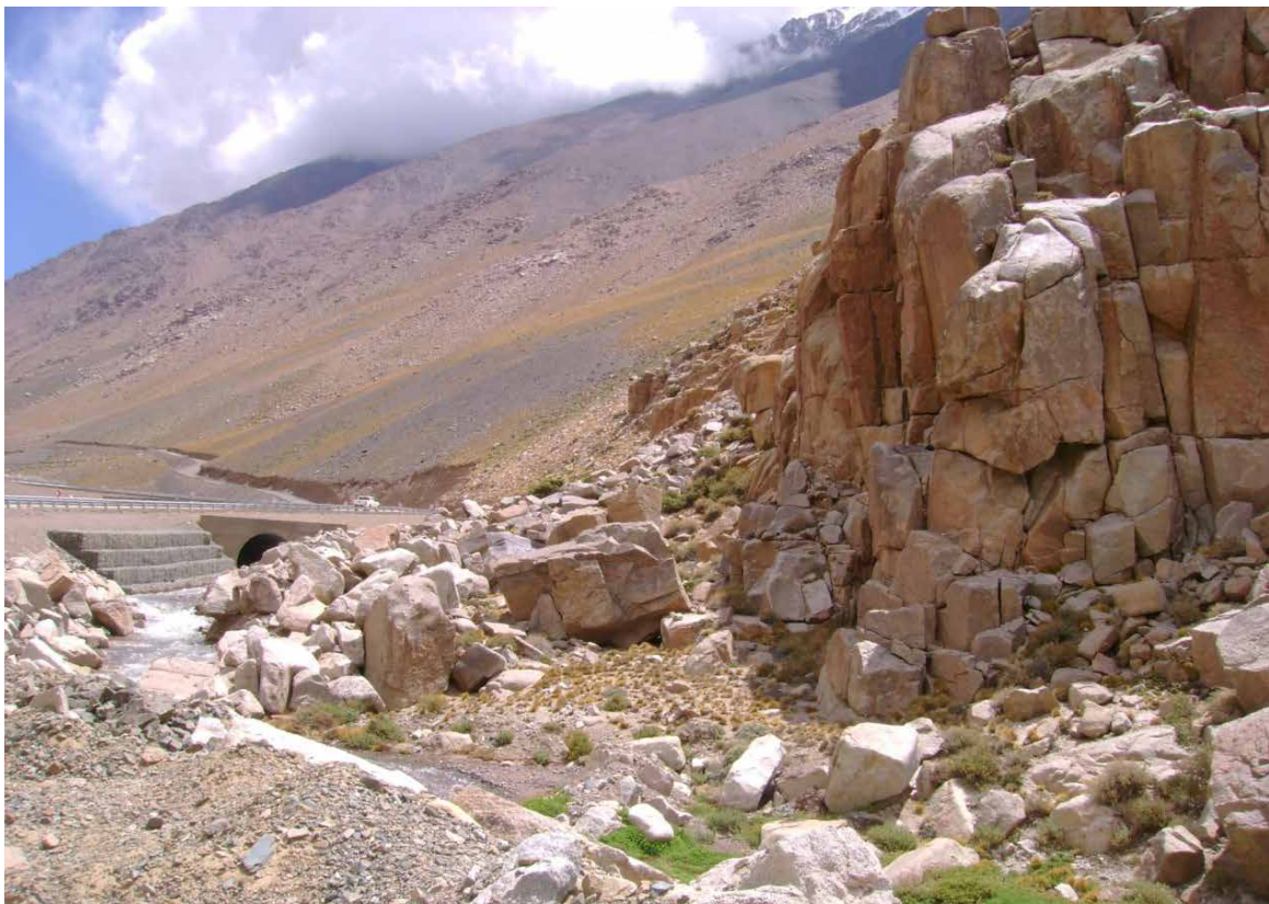
Figura 16. Caídas de roca que pueden generar endicamientos y fenómenos de erosión al pie del terraplén de la ruta.
