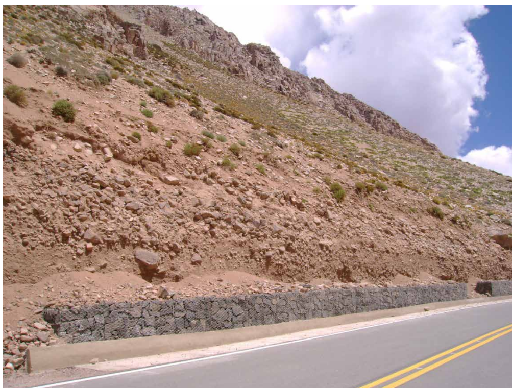
Figura 23. Corte artificial realizado como parte de las obras de construcción de la ruta disectando un talud de caída de rocas. Nótese el tamaño de la acumulación y de los bloques. Los gaviones ubicados al pie serían totalmente ineficaces frente a próximos movimientos.
