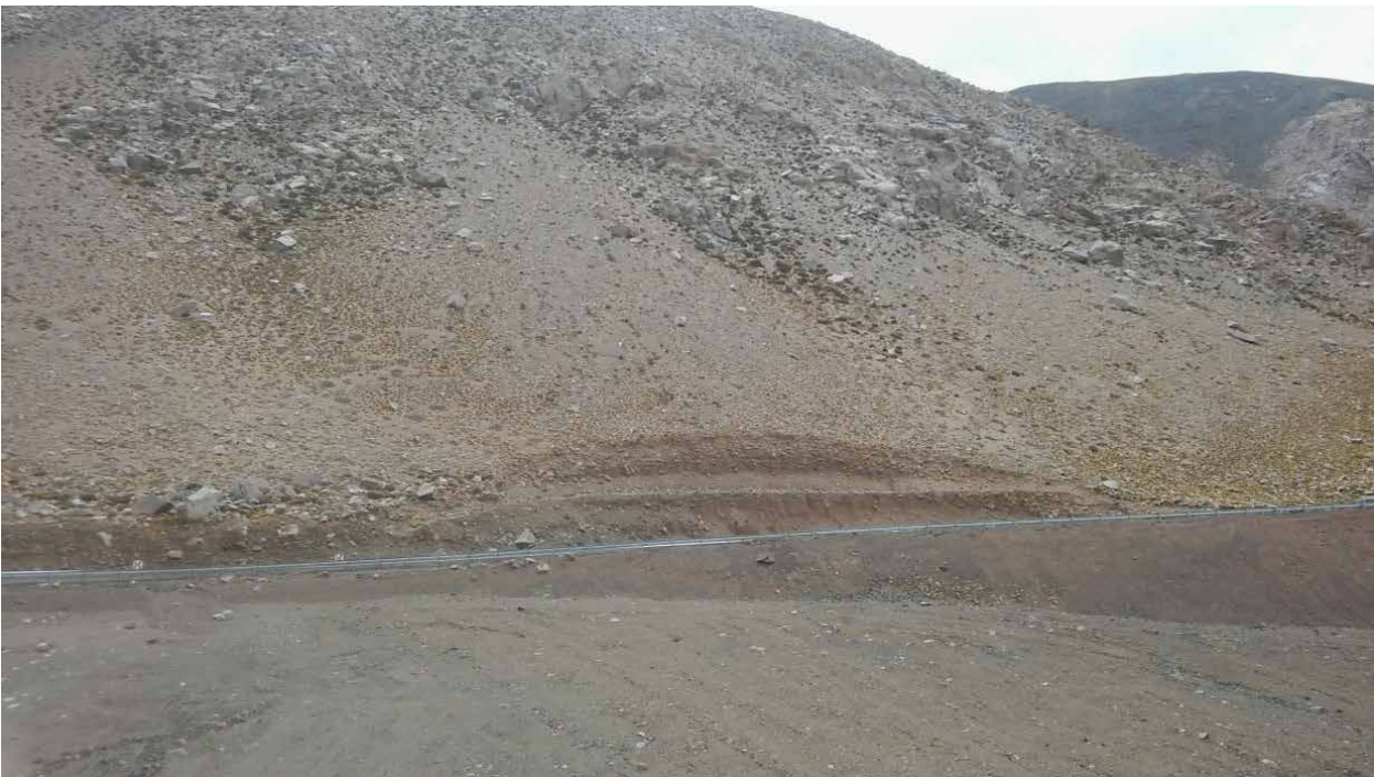
Figura 27. Cortes artificiales de conos de talud. La pendiente resultante es totalmente inestable.
