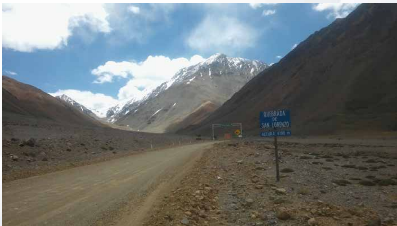
Ubicación aproximada del portal del túnel, en la convergencia de la quebrada de San Lorenzo con la del Agua Negra
