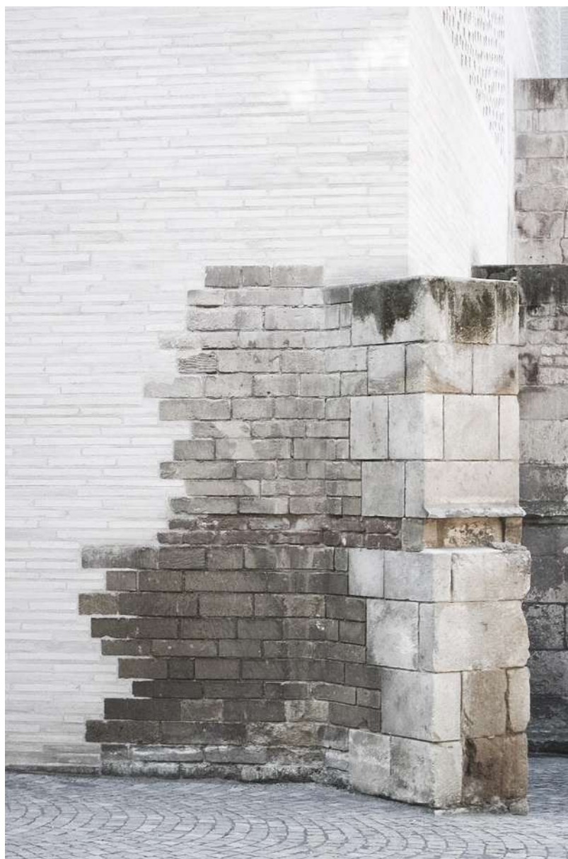
Figura 33 - Detalhe da fachada
