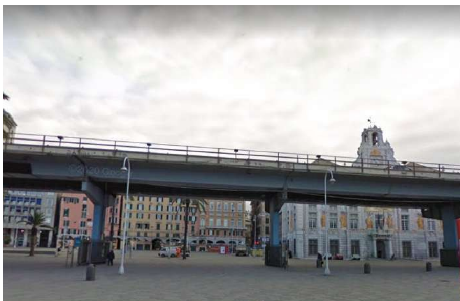
Figura 40 - Vista da cidade de Génova com a sopraelevata
