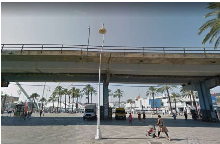
Figura 39 - Vista do porto de Génova com a sopraelevata
