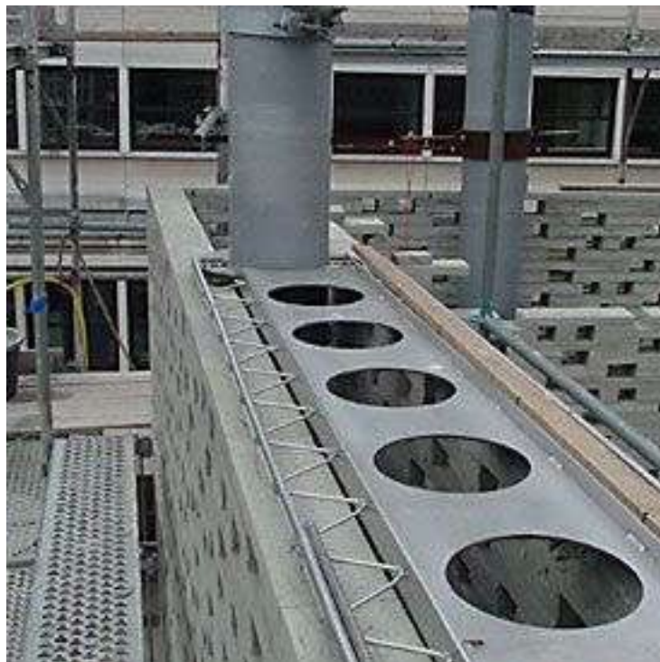
Figura 30 - Pilares em aço para sustentação do novo edifício e as ruínas
