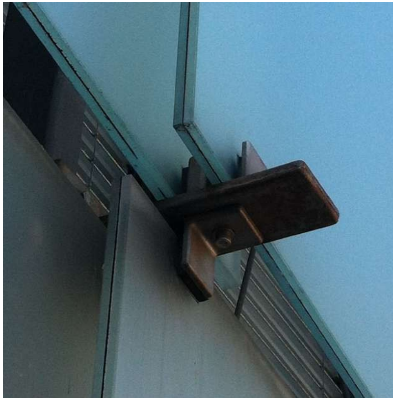
Figura 22 - Detalhe do assentamento do vidro no suporte metálico
