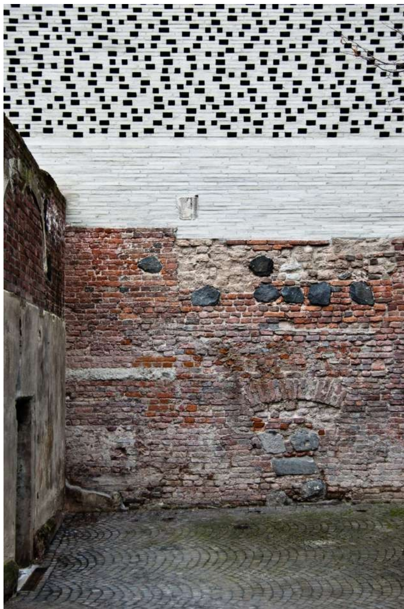
Figura 32 - Detalhe da fachada
