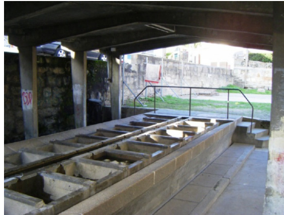
Figura 54 – 29. Lavadouro de Contumil Fotografia do autor.
