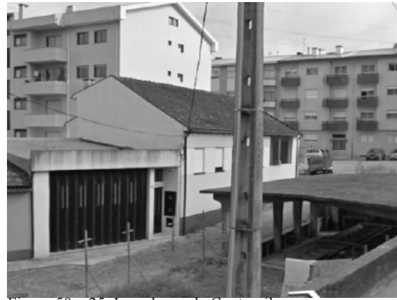
Figura 50 – 25. Lavadouro de Contumil Fotografia do autor.
