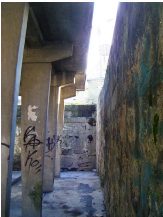
Figura 51 – 26. Lavadouro de Contumil Fotografia do autor.
