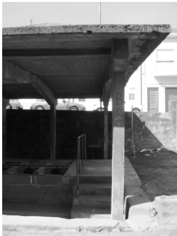
Figura 52 – 27. Lavadouro de Contumil Fotografia do autor.
