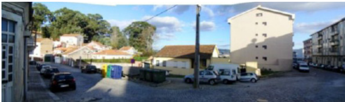
Figura 47 – 22. Rua da Fonte de Contumil Fotografia do autor.
