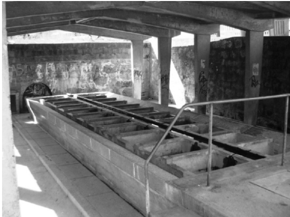
Figura 53 – 28. Lavadouro de Contumil Fotografia do autor.
