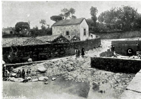
Figura 84 – Lavadouro Público de Contumil Tese de Doutoramento J. Bahia Junior, repositório das Águas do Porto
