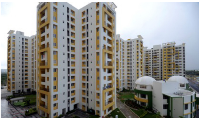
a) The actual building
