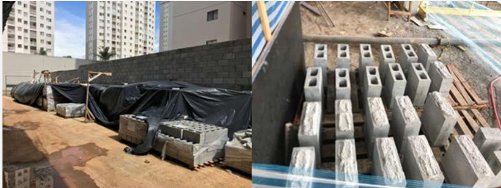
Figura 14 - Armazenamento dos blocos e primas ocos e cheios. Fonte: Autores.
