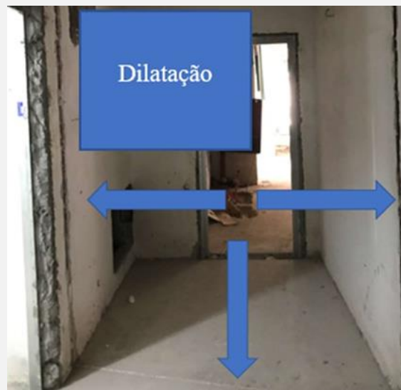
Figura 17 – Juntas de dilatação construídas corretamente. Fonte: Autores.
