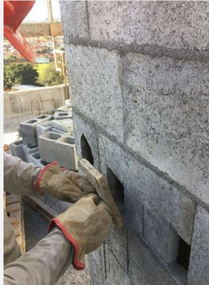
Figura 12 - Fechamento dos pontos de inspeção do graute após a limpeza. Fonte: Autores.
