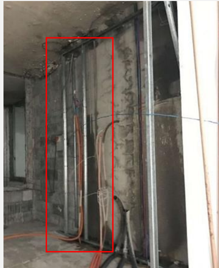
Figura 20 - Shaft parcialmente executado. Fonte: Autores.
