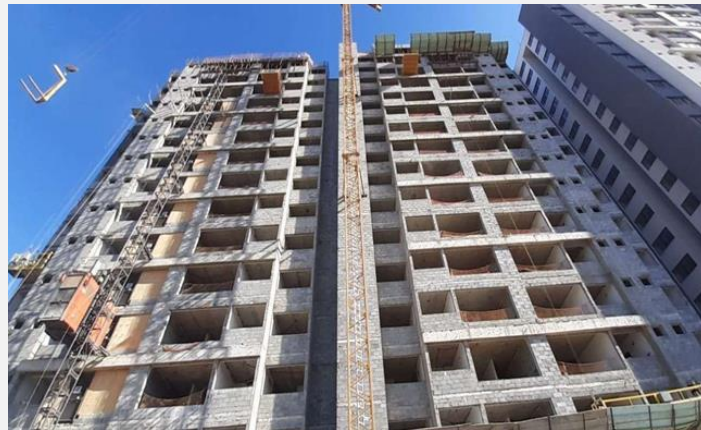
Figura 1 – Fachada do edifício. Fonte: Autores.
