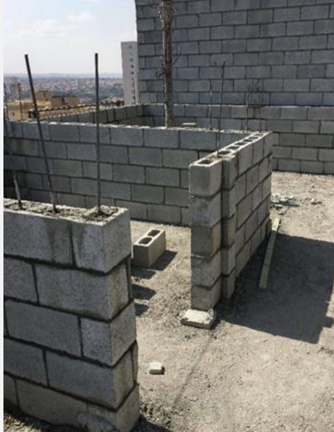
Figura 10 - Paredes grauteadas na quinta fiada. Fonte: Autores.
