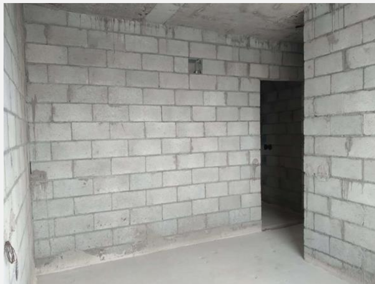
Figura 6 - Parte da parede 27B executada. Fonte: Autores.
