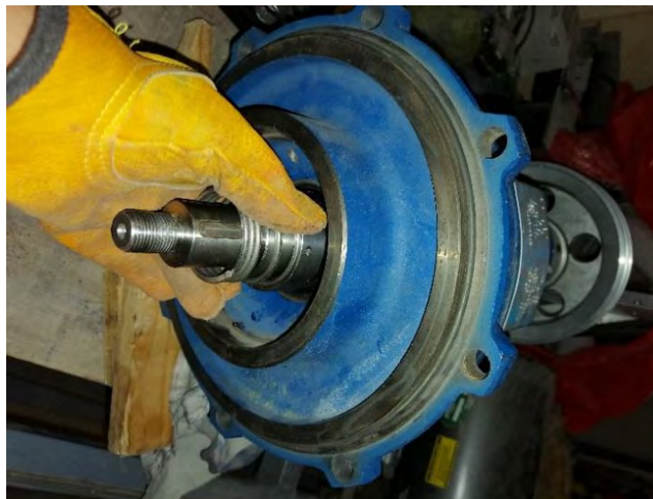
Figura 66: Montaje del sello mecánico. Fuente: Elaboración Propia.
