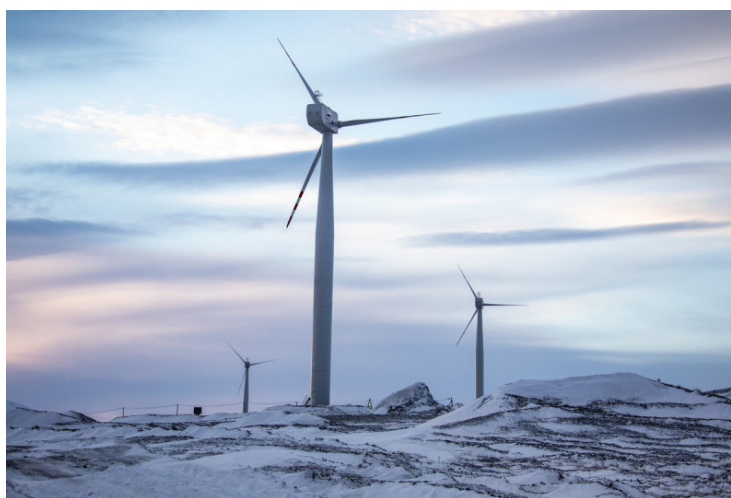
Рисунок 1. Ветроустановки на арктическом побережье
