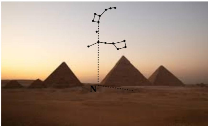
FIGURA 16. Representação esquemática das posições das estrelas Kochab e Mizar nas respectivas constelações das Ursas Menor e Maior usadas para definir o Norte verdadeiro e orientar a construção das pirâmides em relação aos pontos cardeais. Desse modo, em 2467 a.C., um astrônomo egípcio com um simples fio de prumo podia aguardar o alinhamento vertical das duas estrelas, cerca de  $10^\circ$  acima e abaixo do pólo invisível, que forneceria diretamente o Norte verdadeiro. Imagem: Os Autores.
