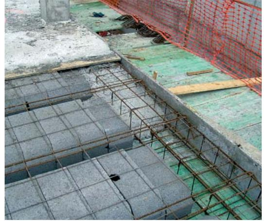
trucción sobre la separación de barras aisladas. En esta situación podríamos recurrir a otros sistemas de empalme que nos permitieran resolver estas problemáticas. Un modo sería utilizando manguitos roscados y otro efectuando soldaduras resistentes, si bien las limitaciones y condiciones técnico-constructivas de cada uno de los dos métodos quedan fuera del ámbito de este artículo.
