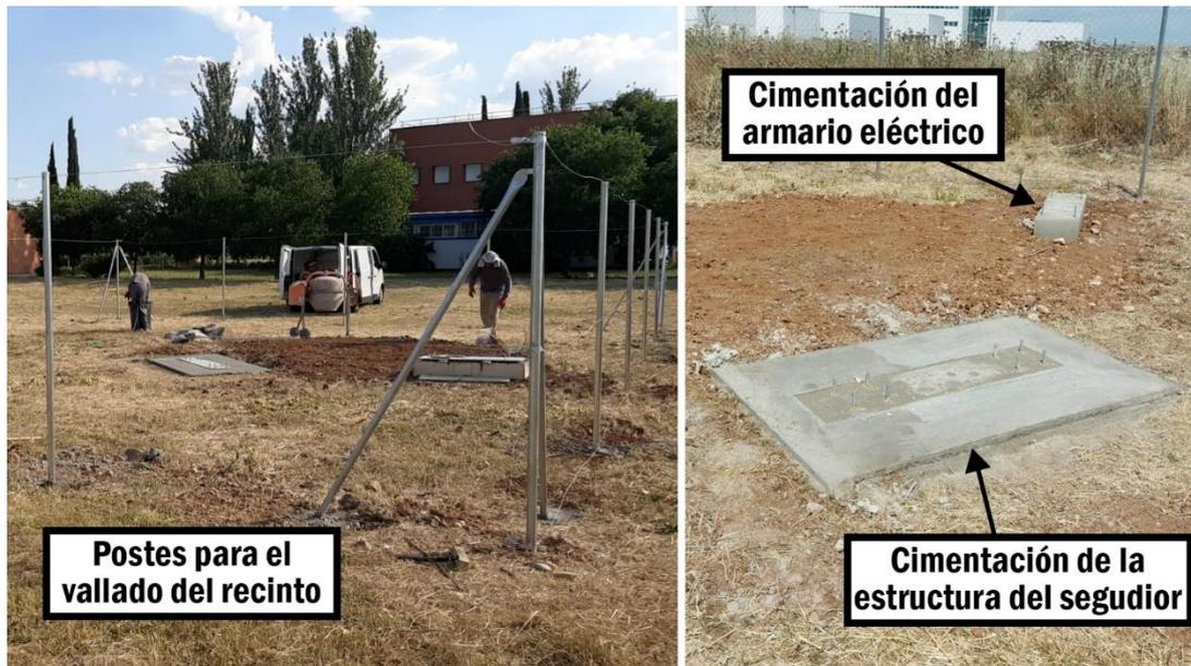
Fig. 5.15. Construcción de las cimentaciones para la estructura de soporte de los paneles y para el armario de control.
