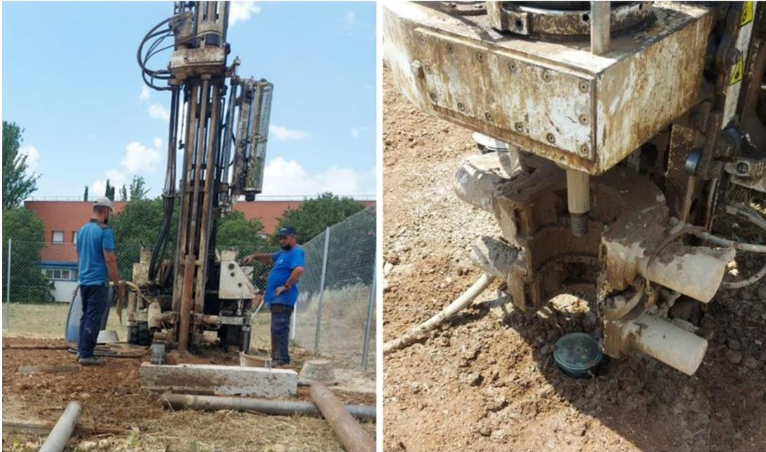
**Fig. 5.16.** Perforación del pozo de inspección para la instalación del intercambiador de calor subterráneo.
