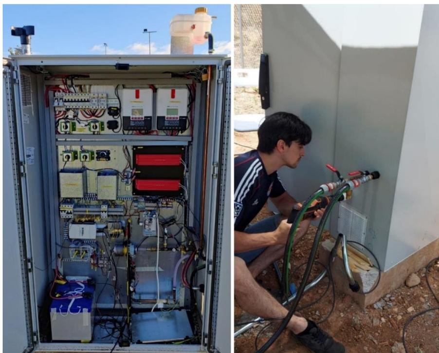
**Fig. 5.18.** Instalación del cuadro de control dentro del armario en la parcela y conexión al prototipo.
