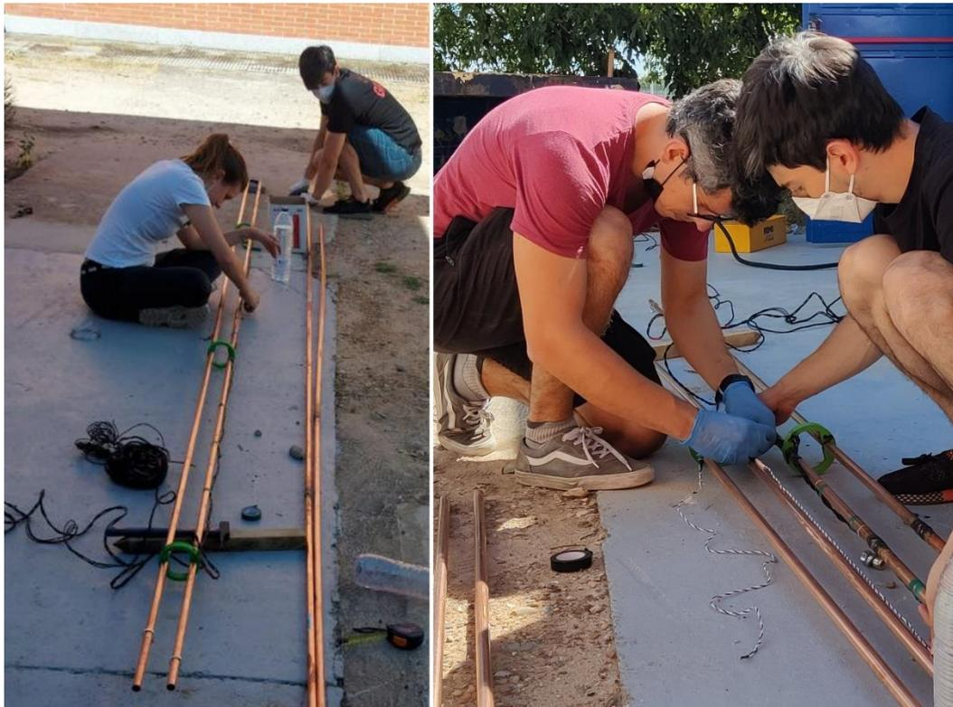
Fig. 5.11. Construcción del intercambiador de calor subterráneo por secciones.
