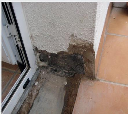
Figura 7: Falta de doblado de la impermeabilización para conseguir una altura de 20cm sobre el solado exterior.
