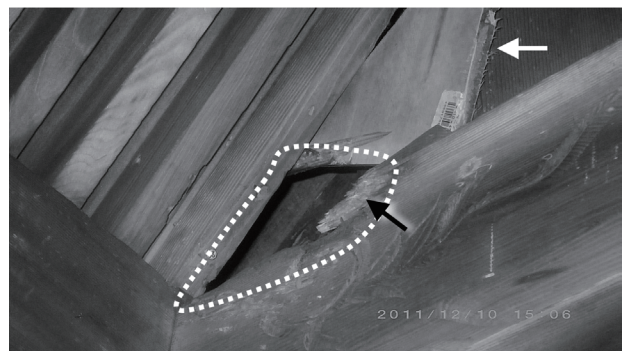
図10. 八幡宮本殿の軒下にあったアライグマによると思われる侵入口(破線). 白矢印がベニヤ様補修材(本文参照). 周囲にたくさん爪跡、足跡や齧り跡(黒矢印)が確認できる.
