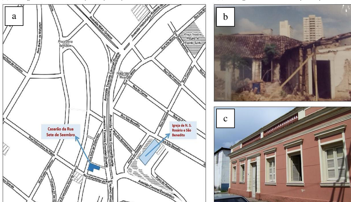
Figura 1 – (a) Localização do Casarão da Rua Sete de Setembro, no Centro Histórico de Cuiabá-MT; (b) Fotografia da fachada principal e posterior na década de 1990; (c) Fotografia da fachada principal em 2008.
