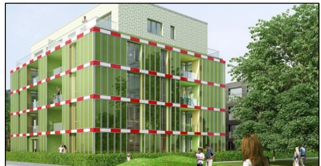
Bild 6: Bioreaktorfassade des BIQ-Algenhaus in Hamburg-Wilhelmsburg [15]
