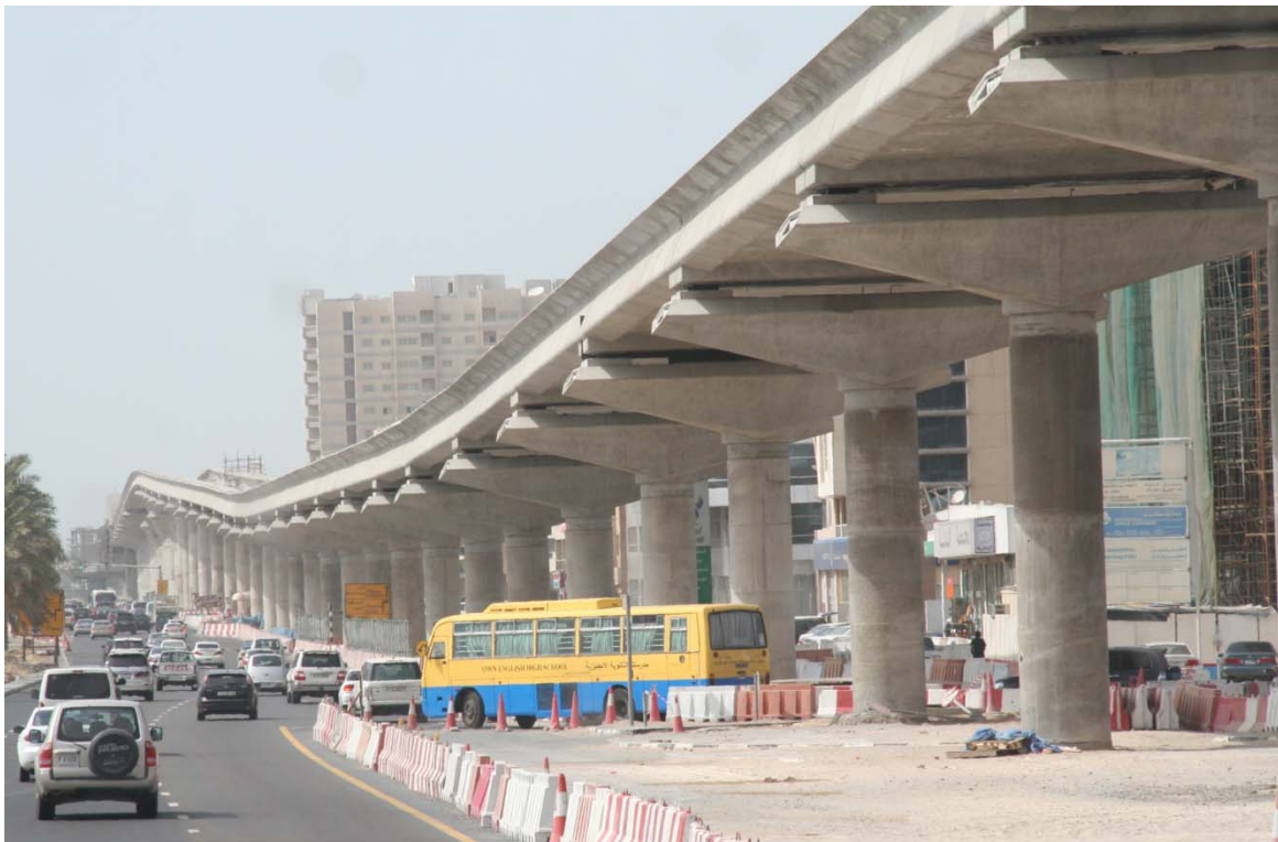
Bild 4: Aufgeständerte Fahrbahn der Dubai Metro (Foto: Horst Werkle)
