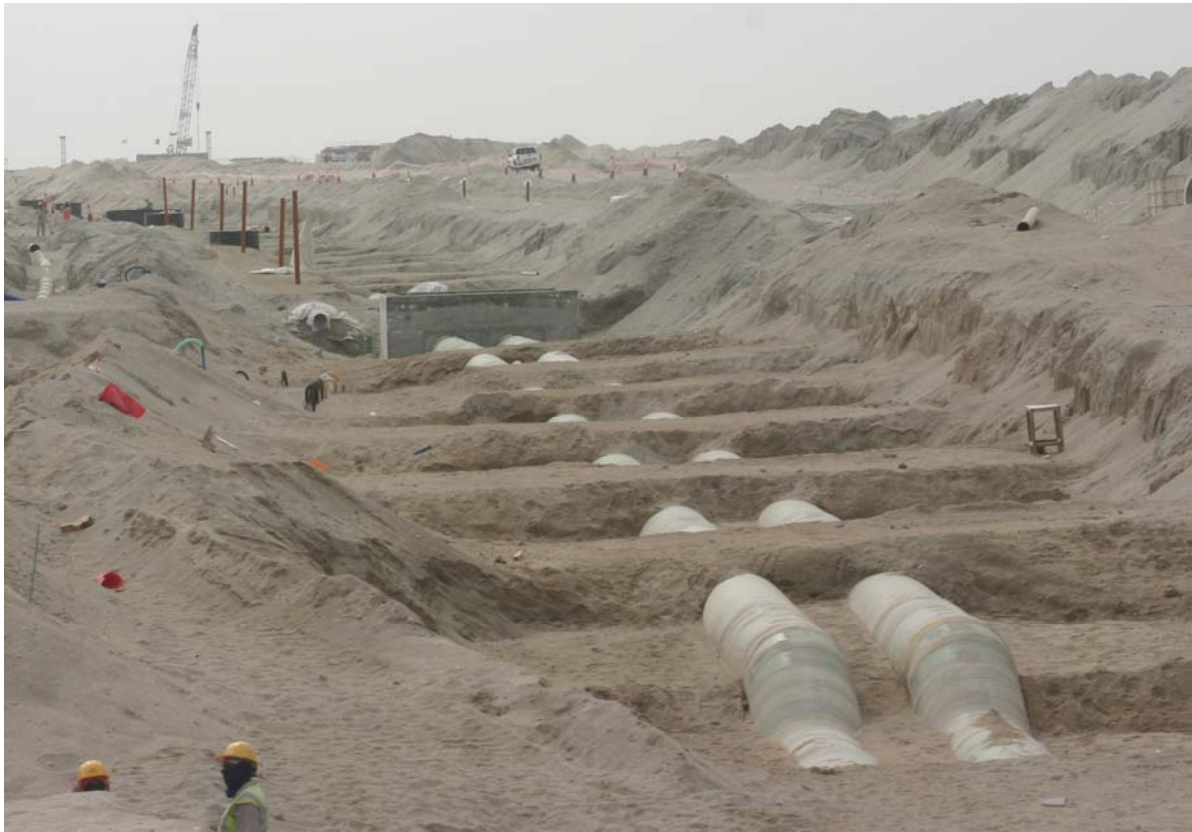
Bild 18: Kanalarbeiten im aufgeschütteten Bereich (Foto: Markus Bartmann)
