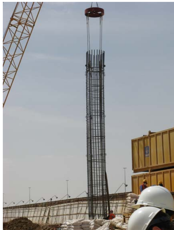
Bild 10: Pfahlbewehrung (Foto: Sabrina Knecht)
