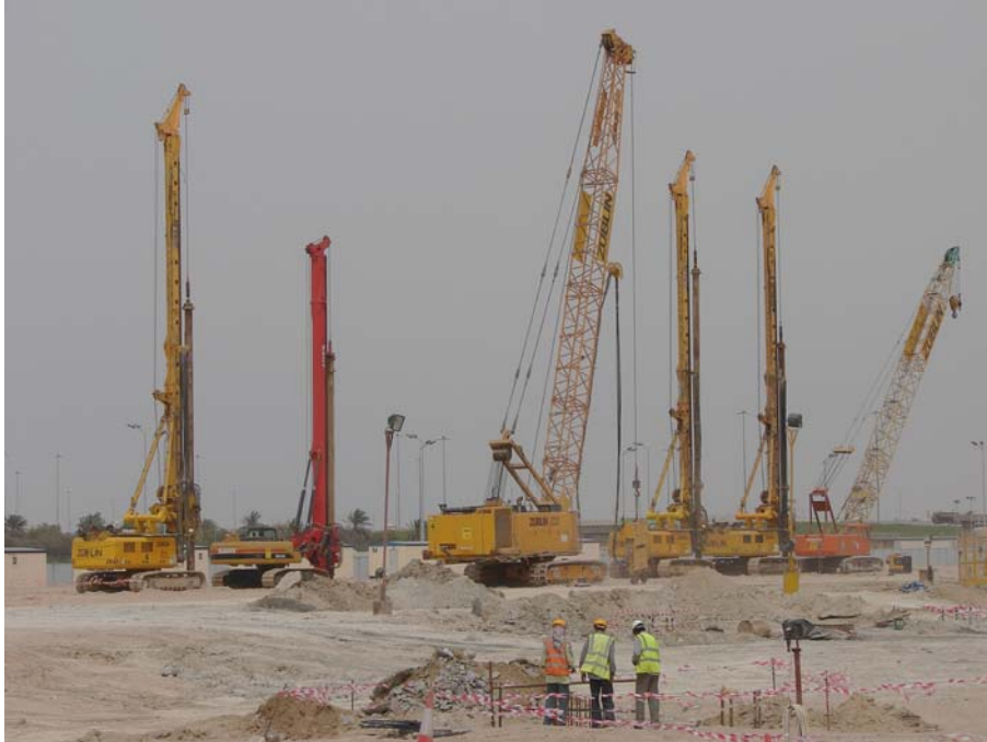
Bild 4: Rüttelstopfpfahlherstellung (Foto: Horst Werkle)
