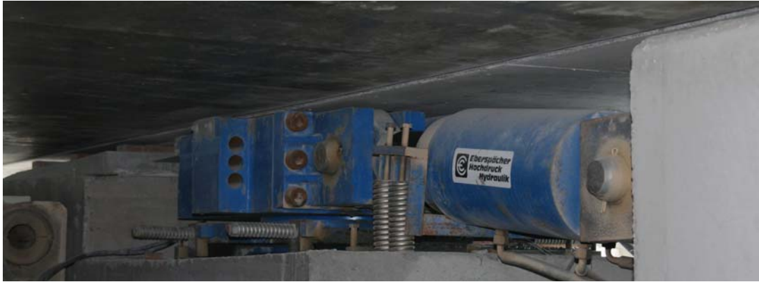
Bild 12: Pressen zum Einschieben der Brücke (Foto: Horst Werkle)
