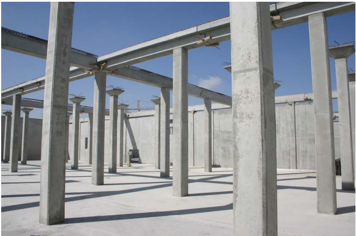
Bild 3: Fertigteilstützen und -balken im Becken (Foto: Markus Bartmann)
