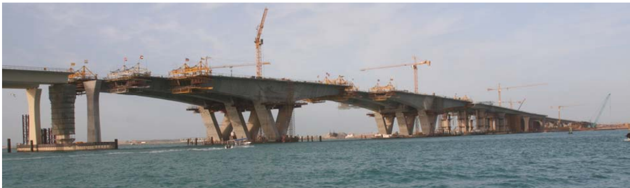
Bild 9: Blick von Süden auf die Brücke (Foto: Horst Werkle)
