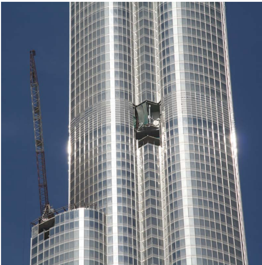
Bild 4: Fassade des Burj Dubai Tower (Foto: Horst Werkle)
