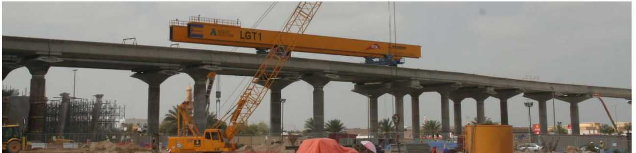
Bild 3: Brückenbaustelle der Metro Dubai (Foto: Horst Werkle)
