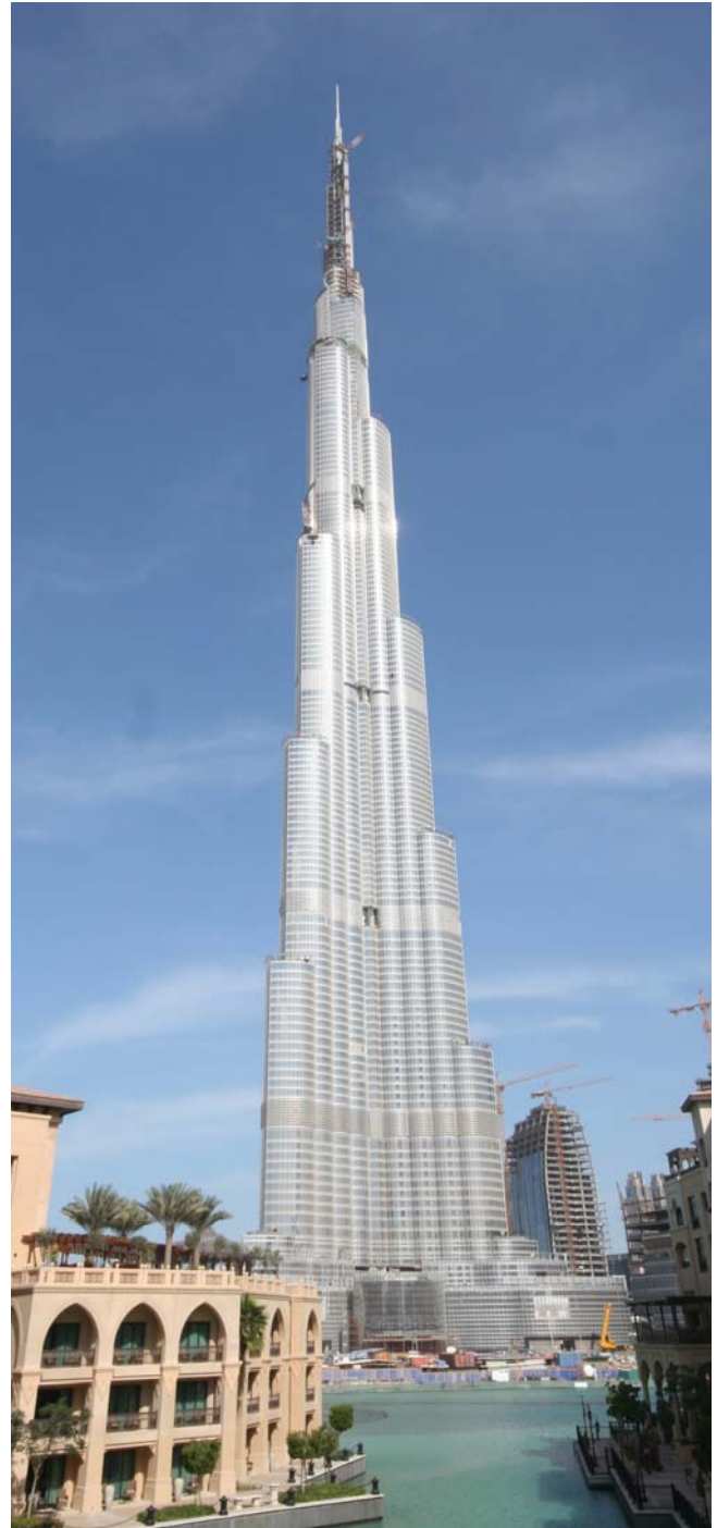
Bild 1: Burj Dubai Tower (Foto: Horst Werkle)
