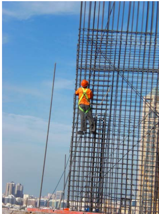
Bild 7: Bewehrungsarbeiten (Foto: Mario Roll)
