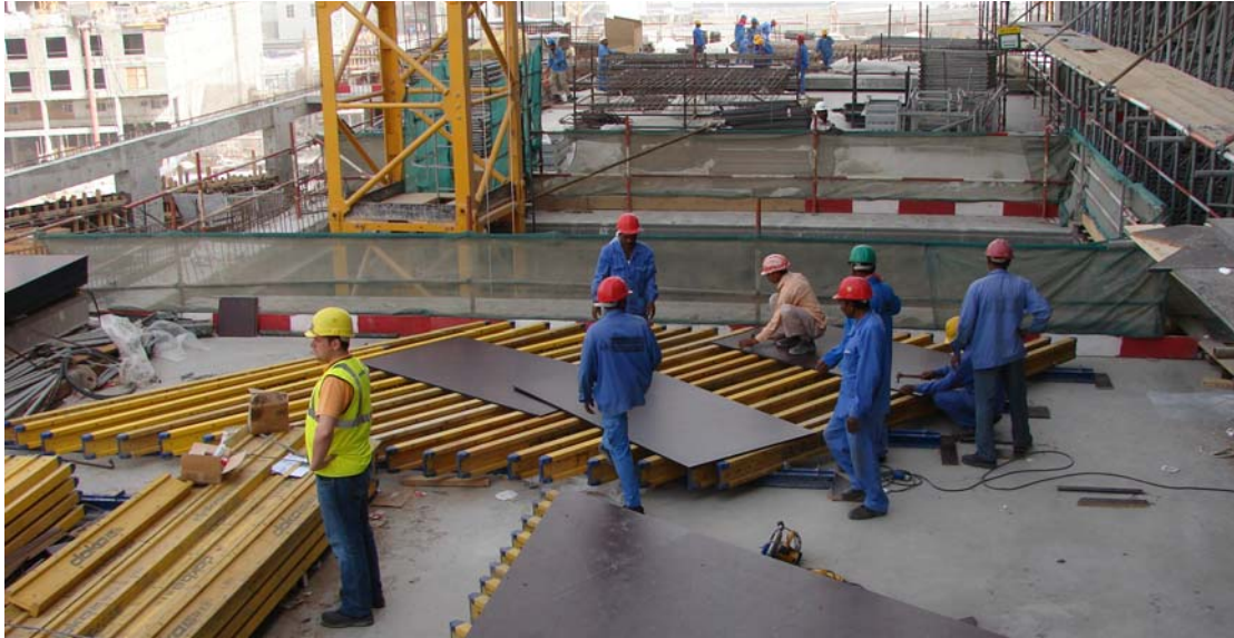
Bild 9: Schalungsarbeiten (Foto: Andreas Lühr)
