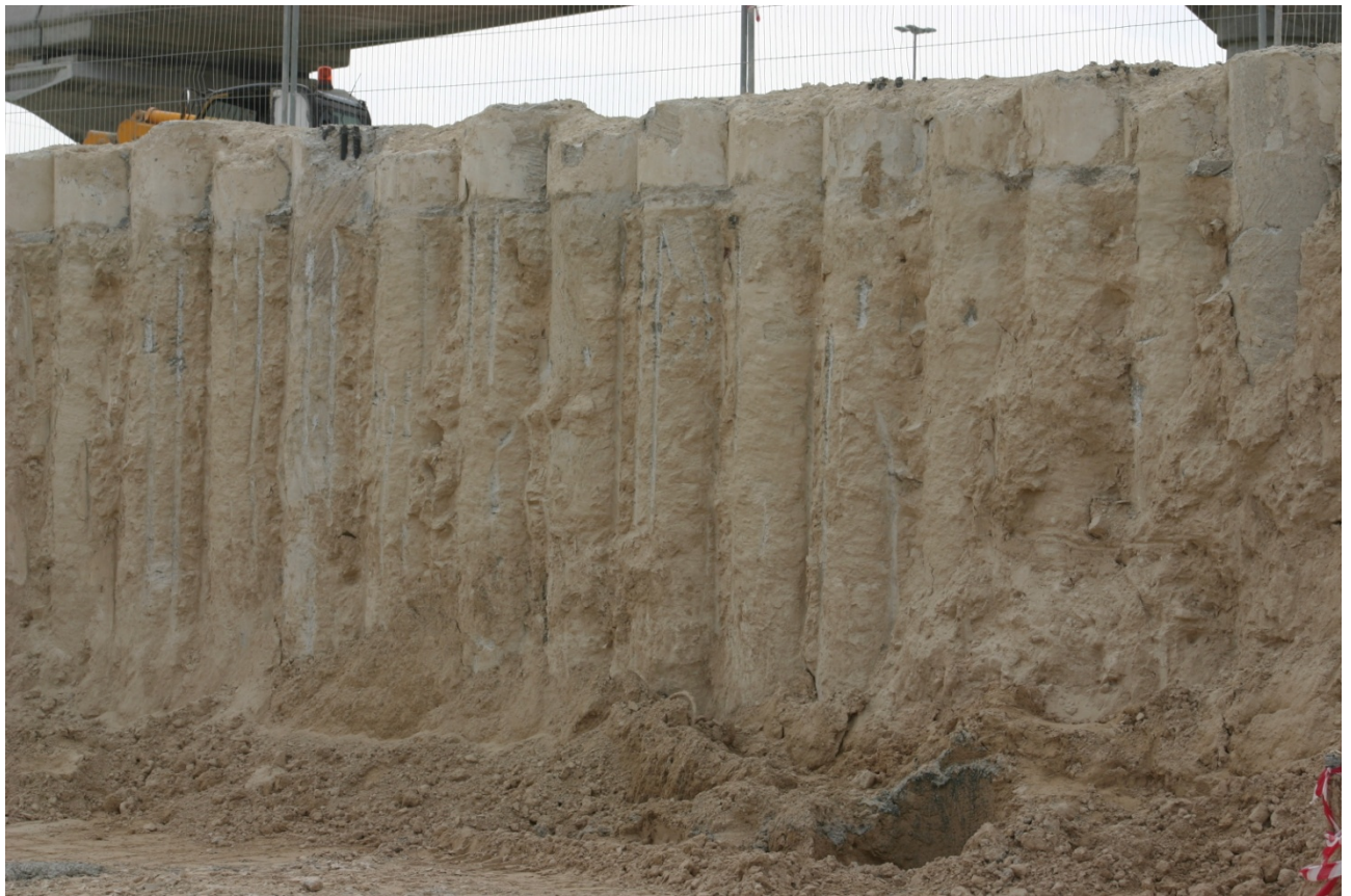
Bild 14: Bohrpfahlwand frisch ausgehoben, nicht gereinigt (Foto: Markus Bartmann)
