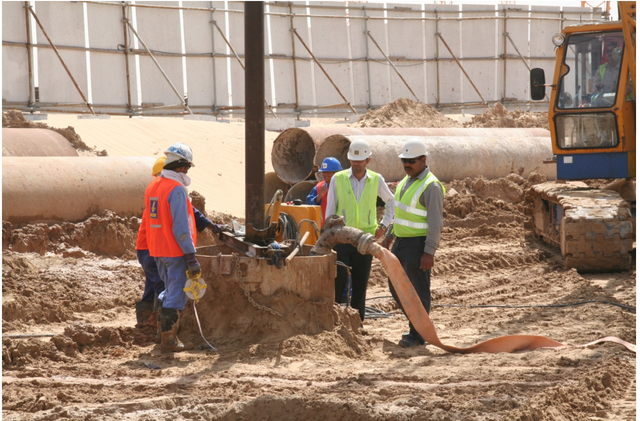
Bild 23: Arbeiter beim Betonieren eines Pfahls – rechts Schlauch zum Abpumpen der Betonsuspension (Foto: Horst Werkle)
