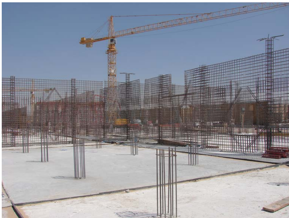
Bild 4: Ortbetonbauteile im Becken (Foto: Andreas Lühr)
