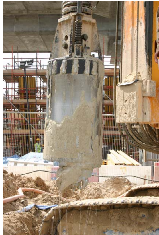
Bild 8: Bohrwerkzeug (Foto: Horst Werkle)
