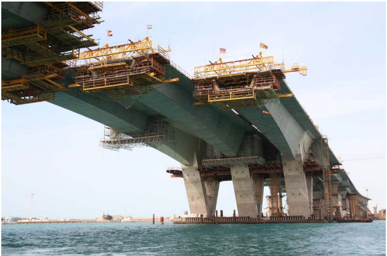
Bild 4: Blick auf das Mittelfeld im Freivorbau (Foto: Horst Werkle)
