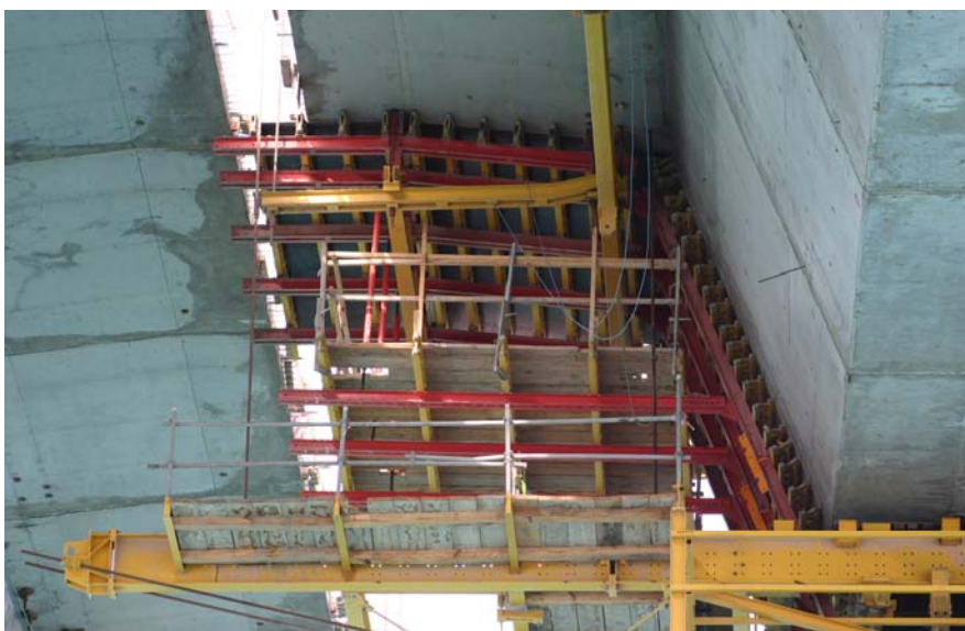
Bild 15: Schalung für einen Vorbautakt (Foto: Markus Bartmann)
