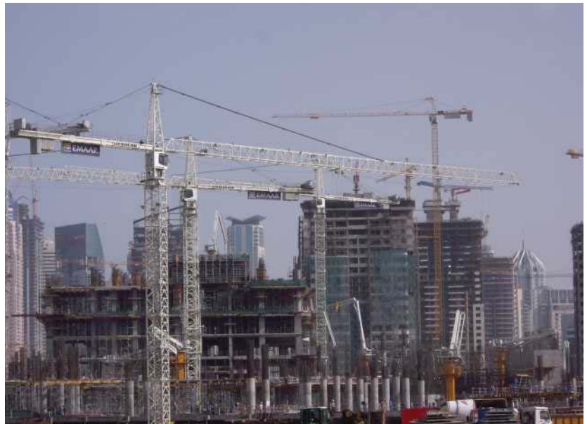
Bild 2: Baukräne in Dubai [14]
