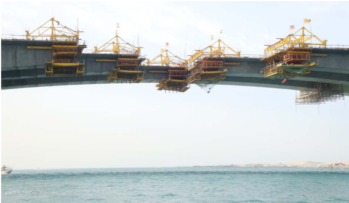
Bild 16: Freivorbau der drei Hohlkästen (Foto: Benjamin Hegner)
