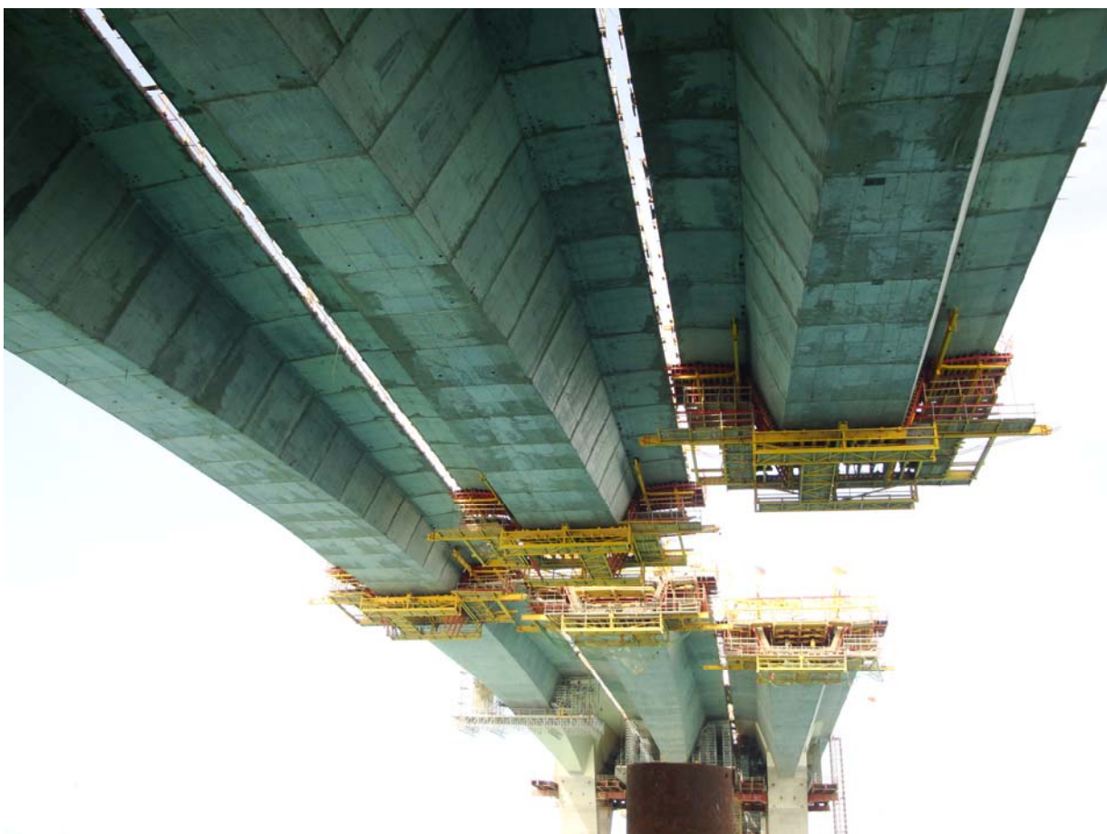
Bild 17: Untersicht der Brücke im Hauptfeld (Foto: Benjamin Hegner)
