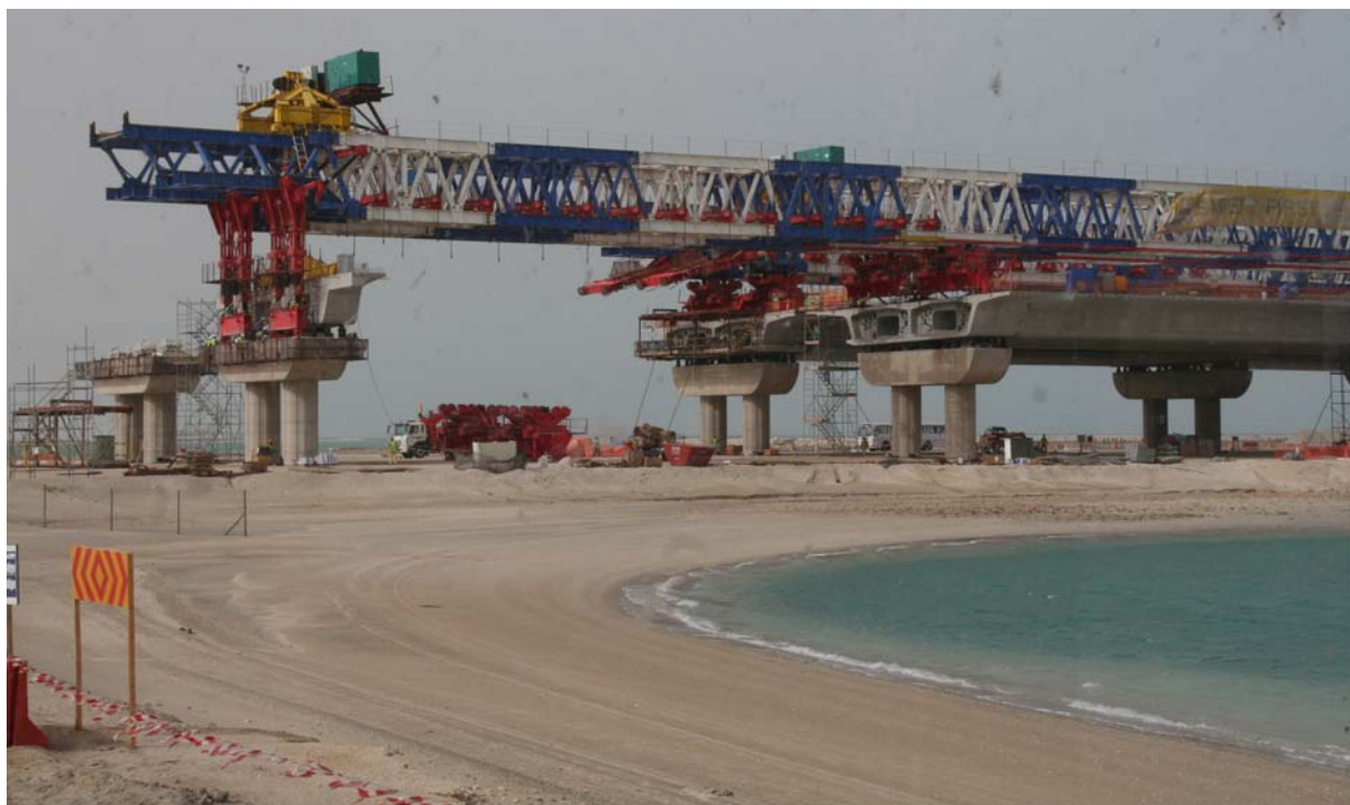
Bild 16: Brückenbaustelle (Foto: Horst Werkle)
