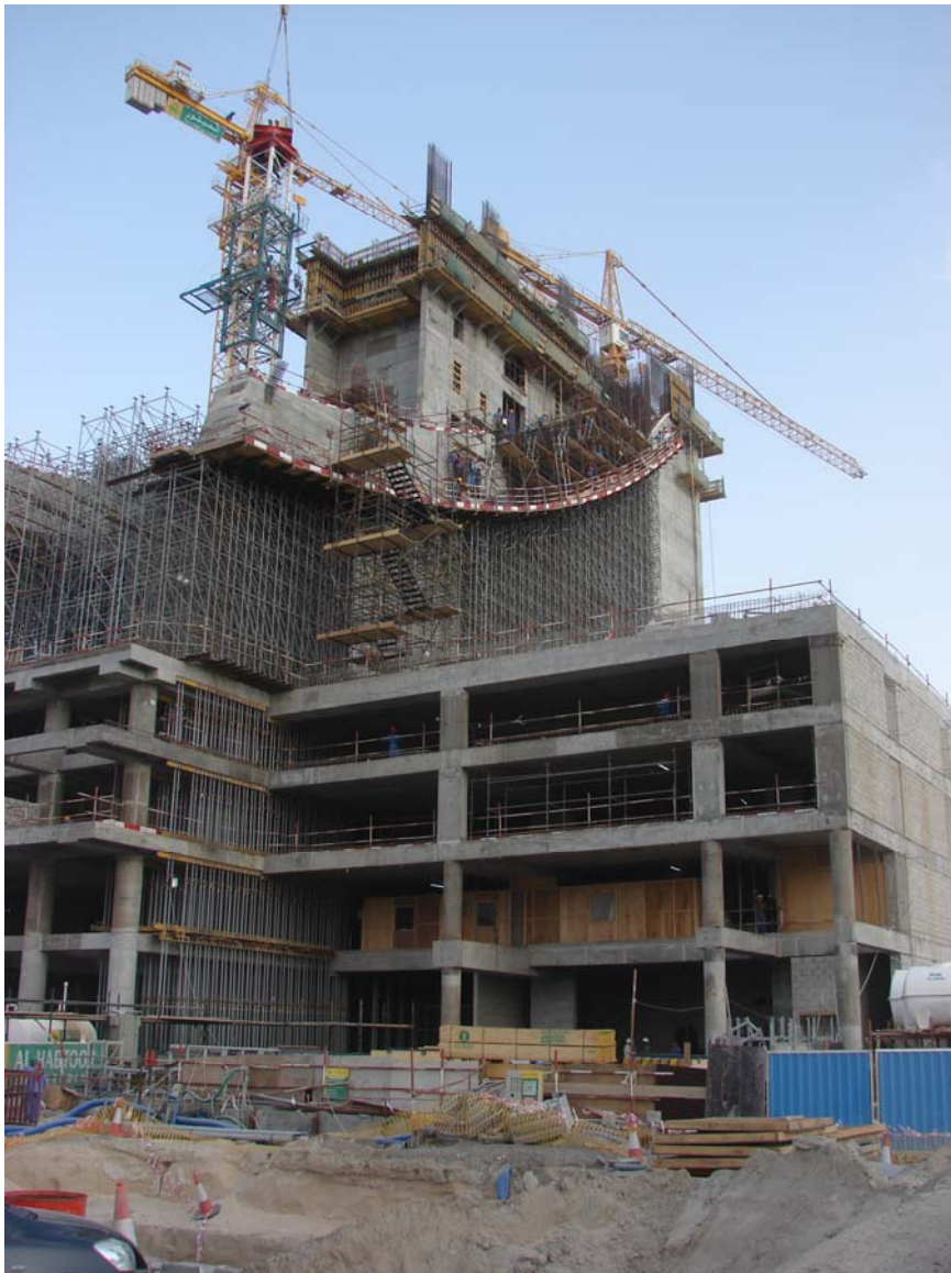
Bild 6: Bauzustand Anfang März (Foto: Andreas Lühr)
