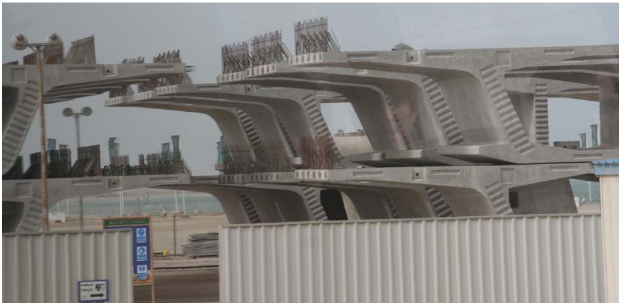
Bild 15: Fertigteile der Brückensegmente (Foto: Horst Werkle)
