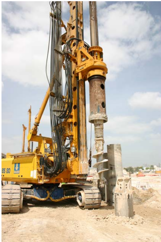
Bild 7: Bohrgeräte (Foto: Markus Bartmann)
