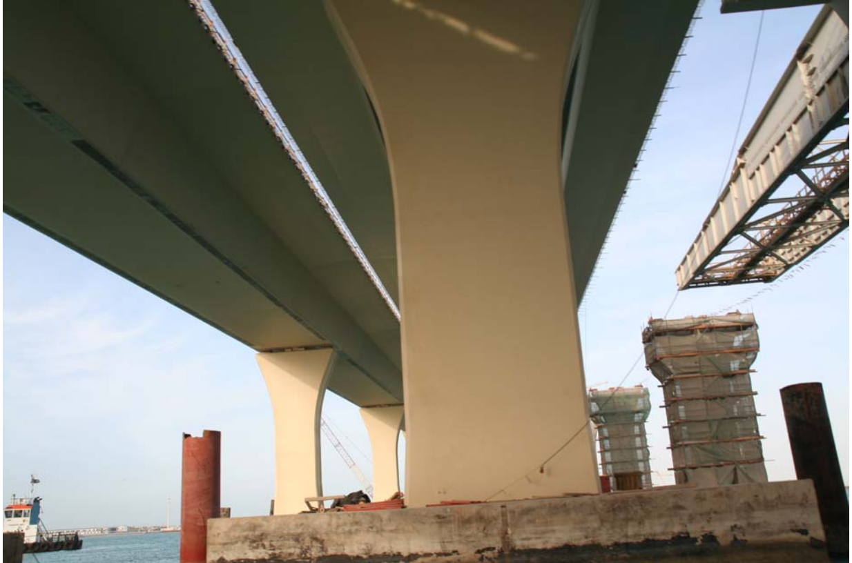
Bild 6: Fertiggestellte und mit Anstrich versehene Brückenteile auf der Abu Dhabi Seite (Foto: Horst Werkle)
