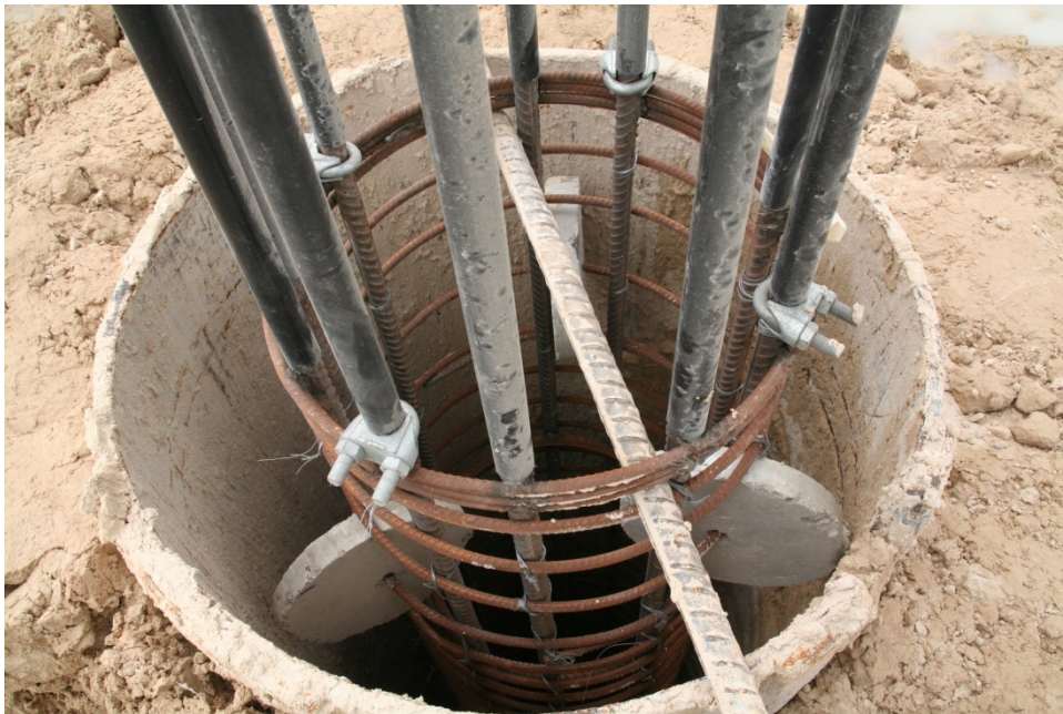
Bild 11: Bohrpfahl mit Verrohrung vor dem Betonieren (Foto: Horst Werkle)
