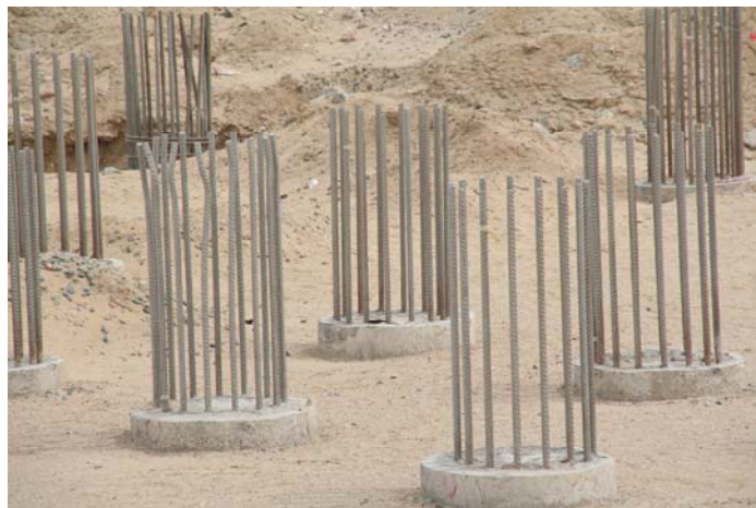
Bild 5: Fertiggestellte Pfahlköpfe (Foto: Horst Werkle)
