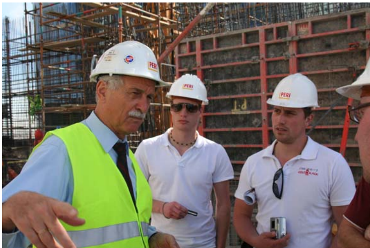
Bild 6: Herr Rau erläutert den Schalungseinsatz (Foto: Horst Werkle)
