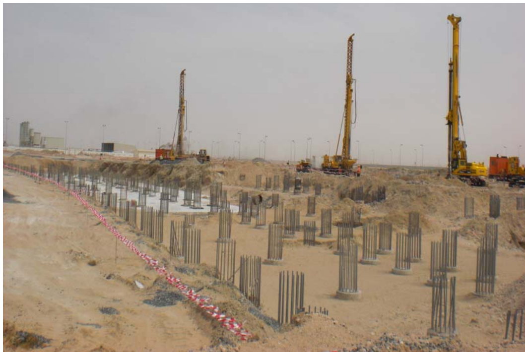
Bild 2: Bohrpfähle unter den Zuschauerrängen mit Anschlussbewehrung (Foto: Mario Roll)
