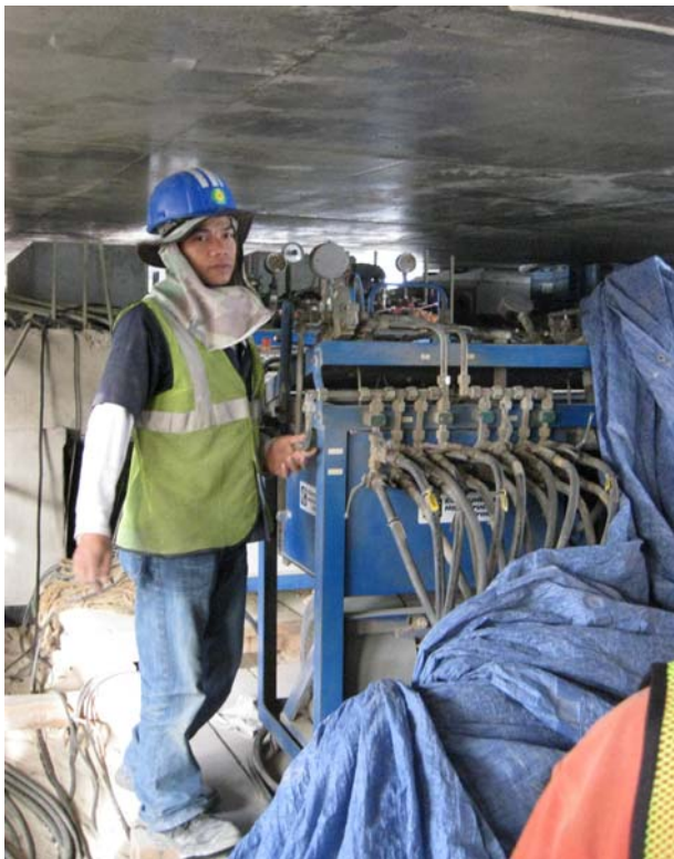
Bild 11: Kompressoren für die Pressen (Foto: Christian Vogel)
