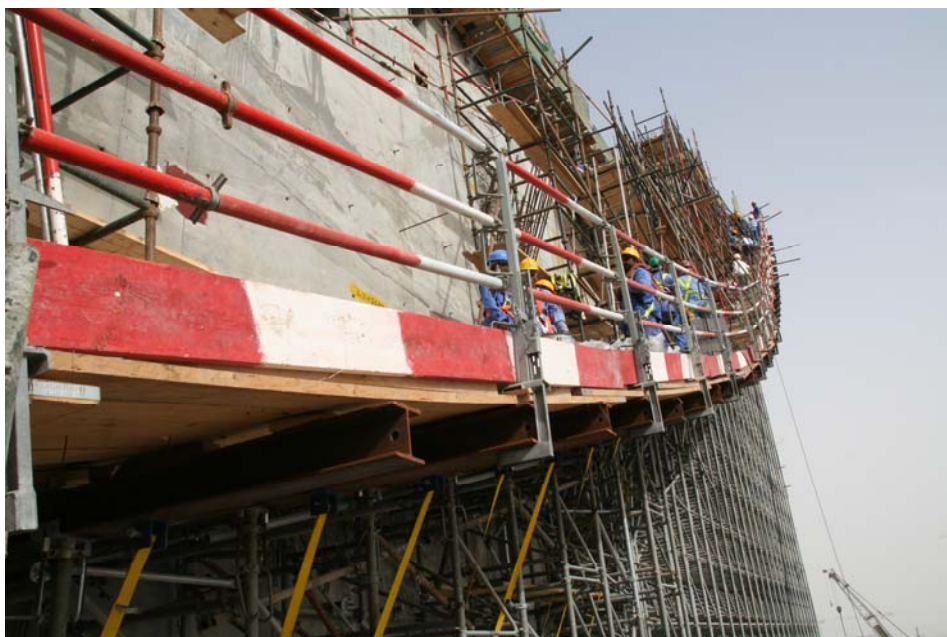
Bild 13: Arbeits- und Fangerüst (Fotos: Horst Werkle)
