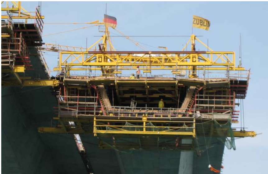
Bild 14: Erstellung eines Hohlkastens im Freivorbau (Foto: Christian Vogel)
