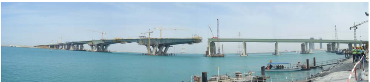
Bild 3: Gesamtansicht der Saadiyat Brücke (Foto: Thomas Wagner)
