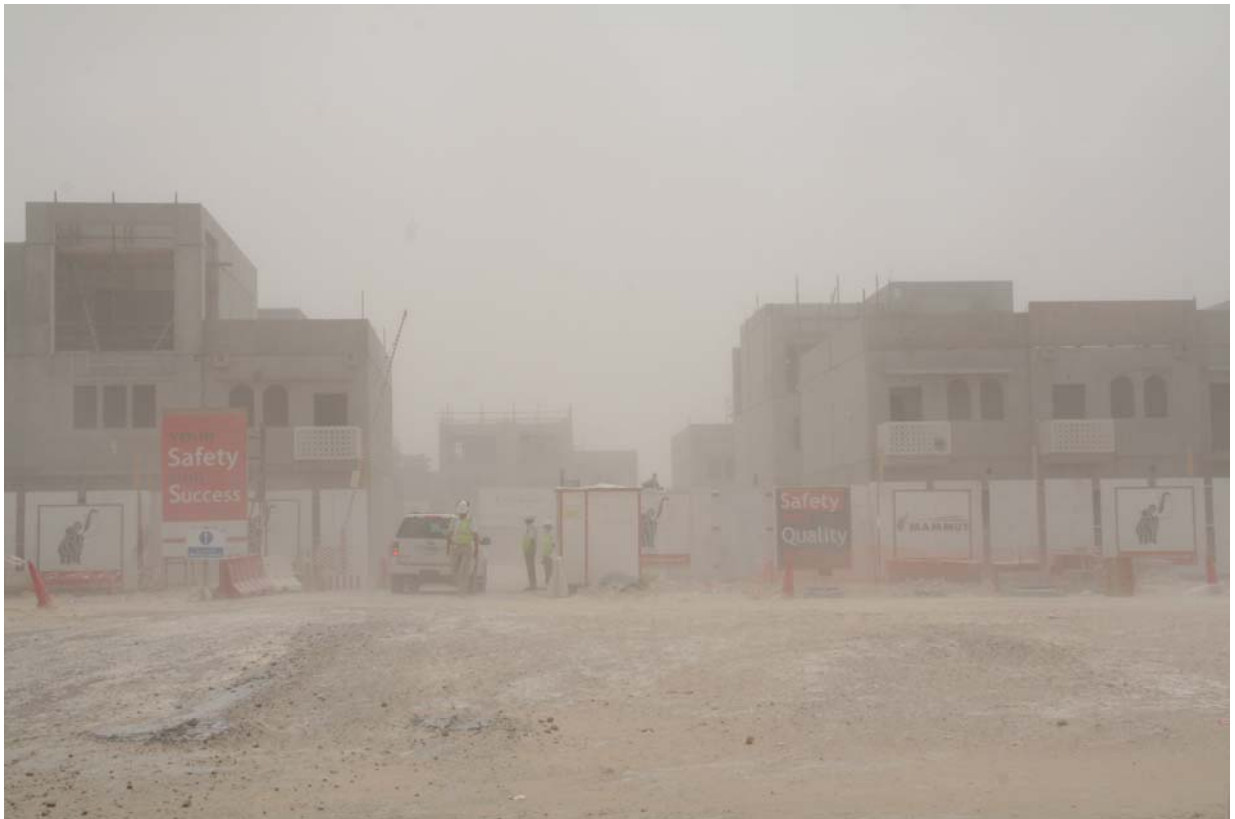
Bild 5: Sandsturm auf der Baustelle (Foto: Horst Werkle)
