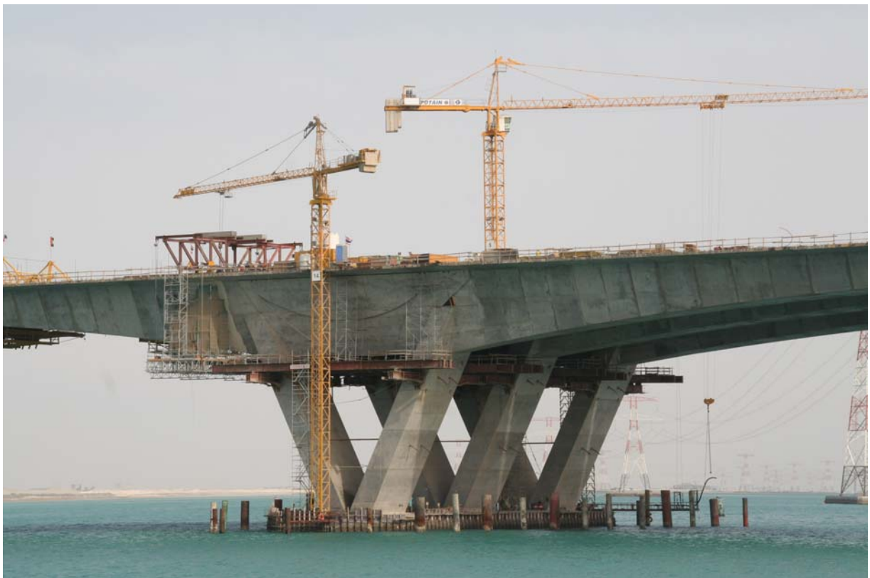
Bild 5: Einer der V-förmigen Pfeilerdrillingen (Foto: Horst Werkle)
