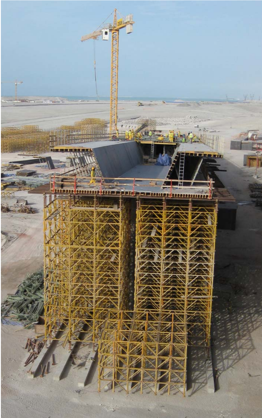
Bild 19: Lehrgerüst (Foto: Christian Vogel)
