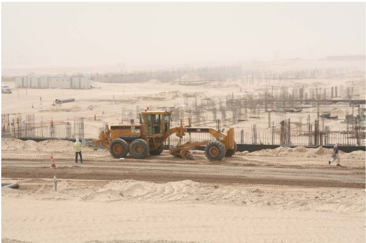
Bild 4: Waterfront Baustelle bei aufkommendem Sandsturm (Foto: Horst Werkle)
