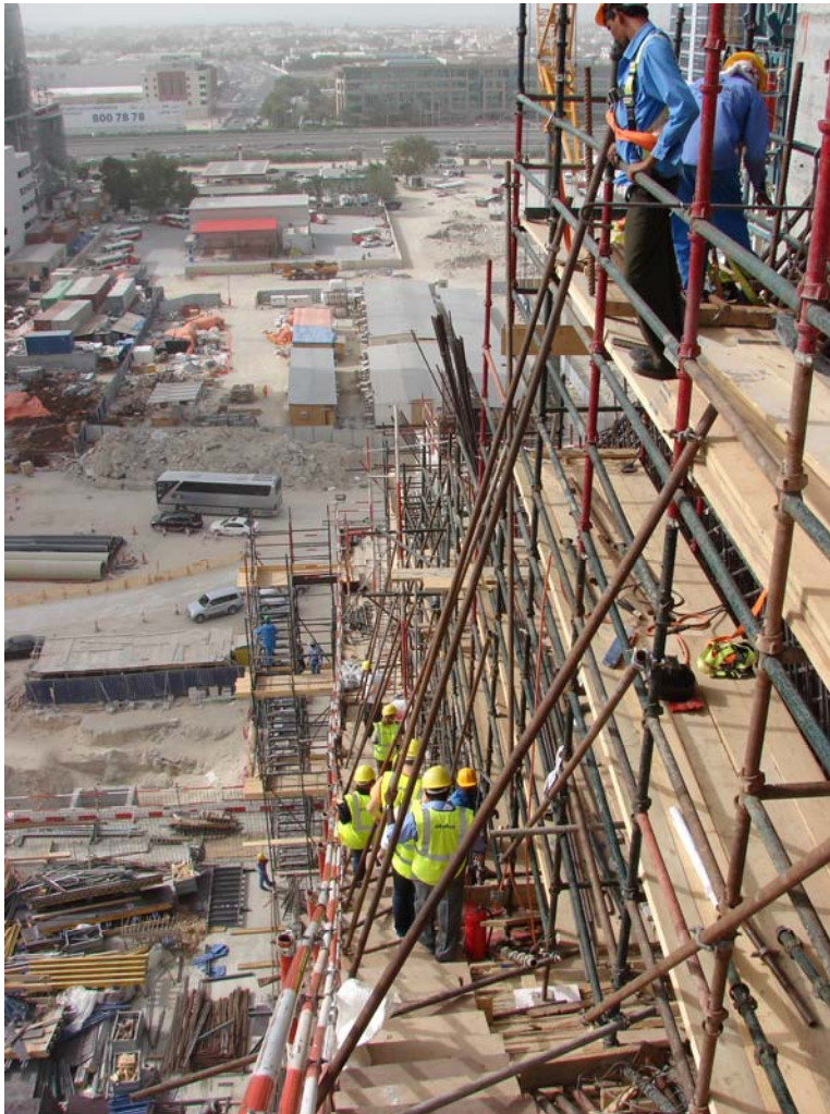
Bilder 11/12: Arbeits- und Fangerüst / Sicherheitshinweise (Fotos: Andreas Lühr)
