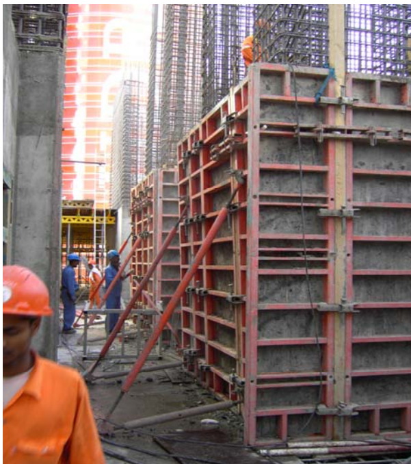
Bild 3: TRIO 330 im 16. Obergeschoss
