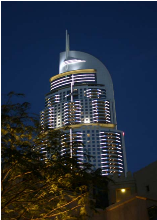
Bild 2: The Address (Foto: Markus Bartmann)
