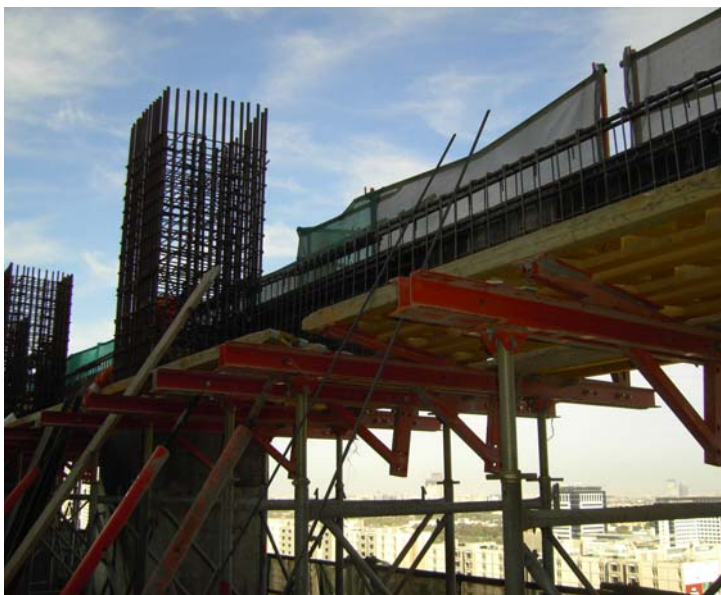
Bild 2: Randunterzug mit Tischmodul
