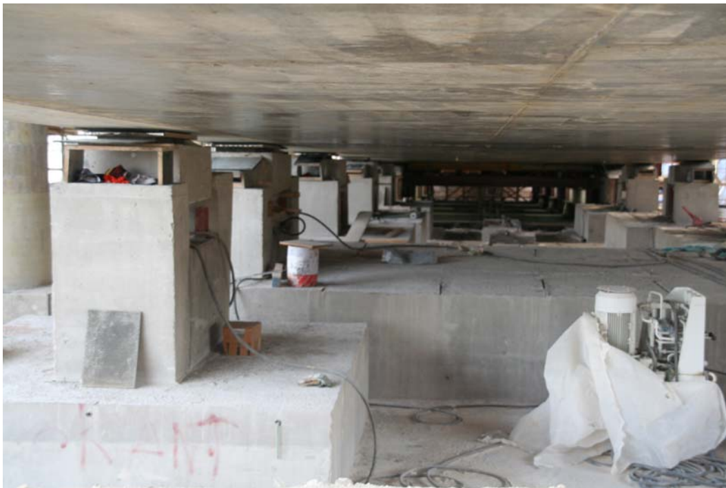
Bild 13: Gleitlager zum Einschieben der Brücke (Foto: Horst Werkle)
