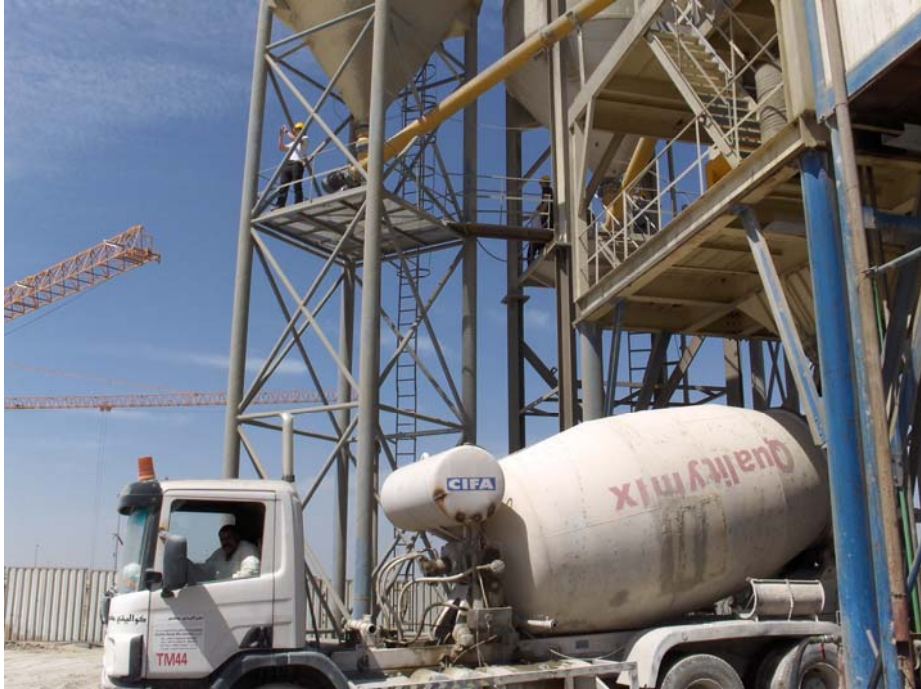
Bild 2: Betonwerk auf der Baustelle (Foto: Wolfgang Francke)
