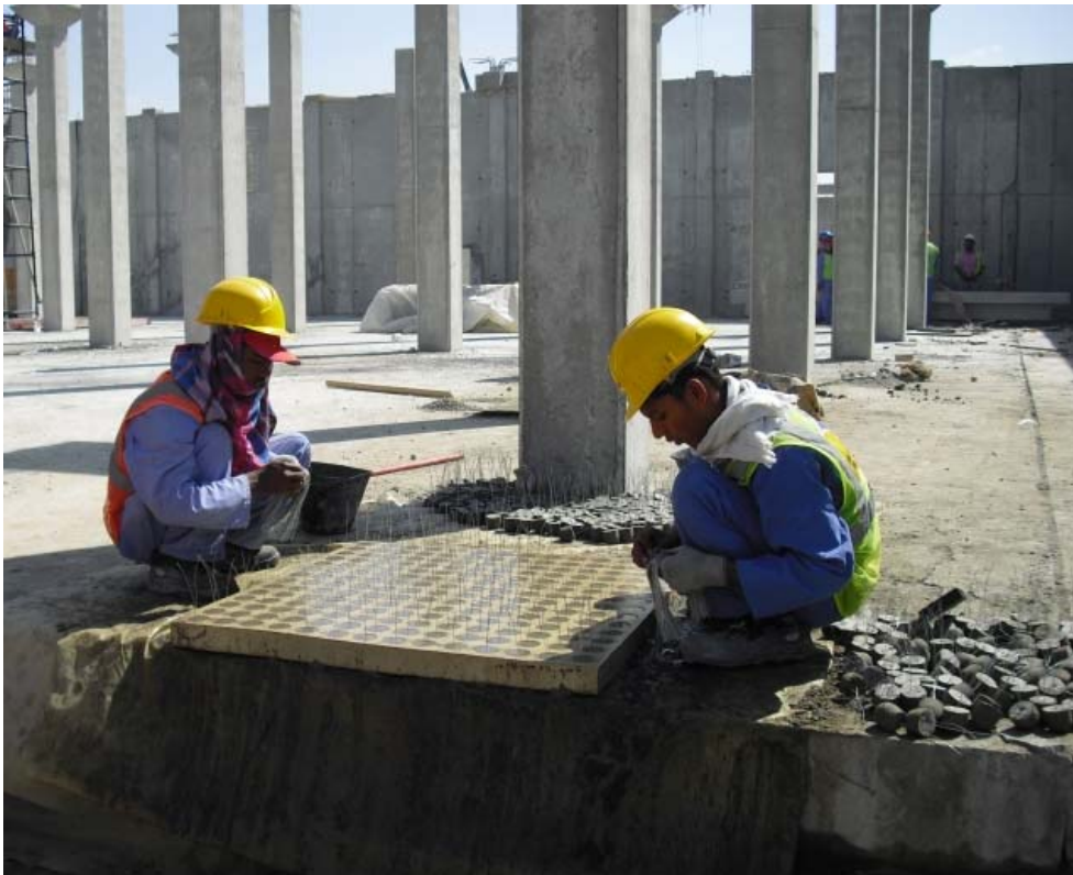
Bild 6: Herstellung von Beton-Abstandshaltern (Foto Marco Schweizer)
