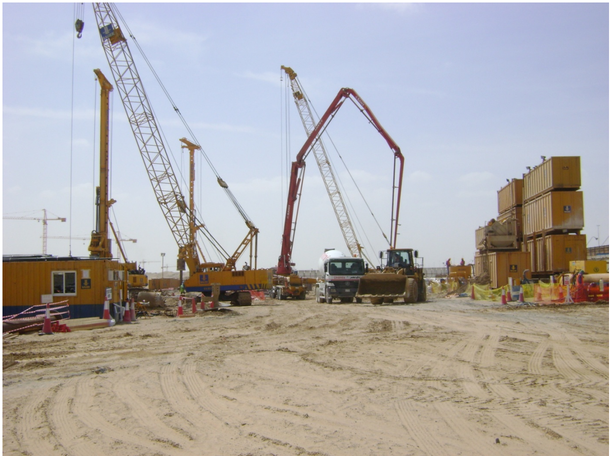
Bild 21: Auf der Baustelle des I&M Tower
