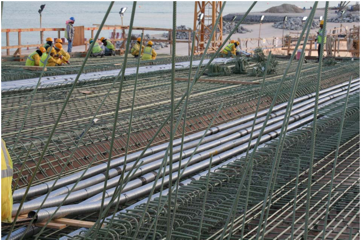
Bild 10: Zweites Taktbett mit Bewehrung (Foto: Horst Werkle)
