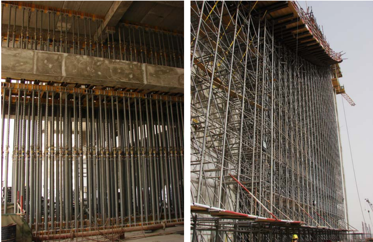
Bilder 7/8: Schwerlaststützen / Traggerüst Fa. Doka (Fotos: Andreas Lühr)
