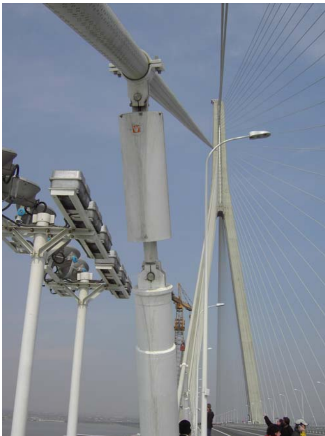
Bild 9: Schwingungsdämpfer (Foto: Matthias Bachmann)
