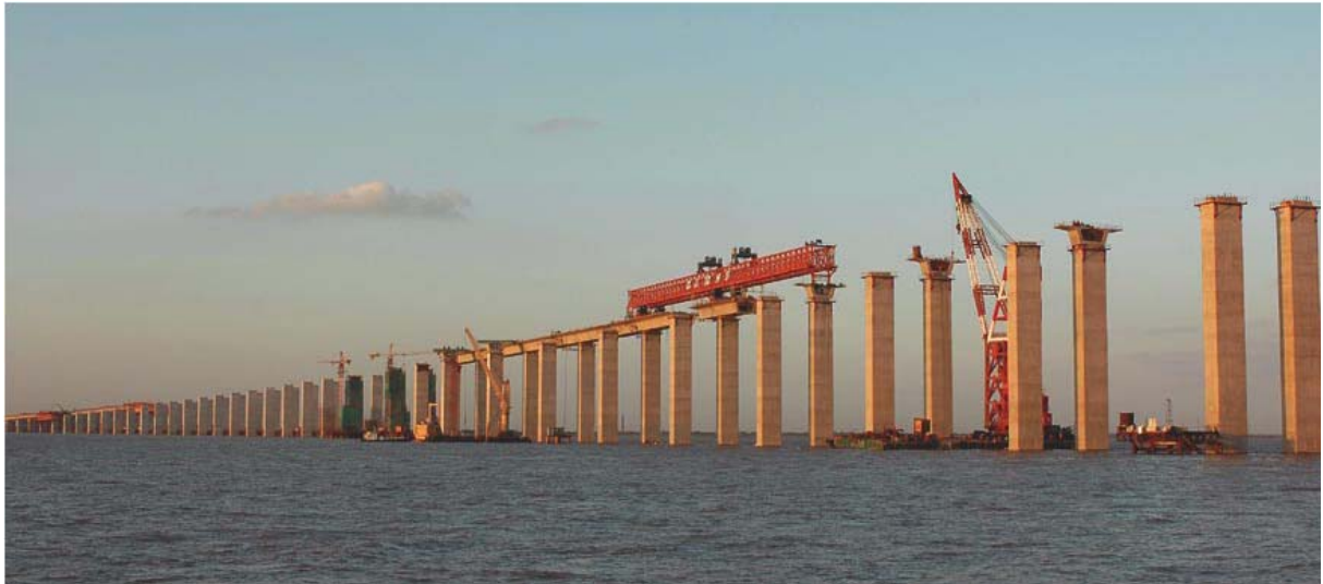
Bild 12: Montage Betonfertigteile der nördlichen Zufahrt [4]
