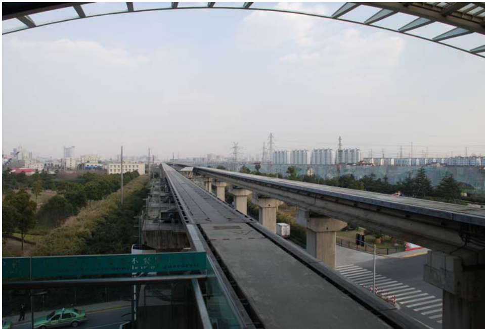
Bild 2: Fahrweg des Maglev-Trains in Shanghai (Foto: Dominik Mölder)
