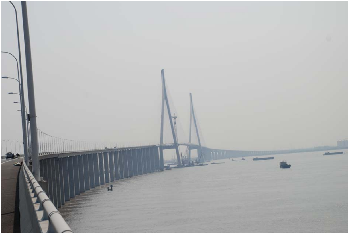
Bild 2: Seitenansicht der Brücke (Foto: Dominik Mölder)
