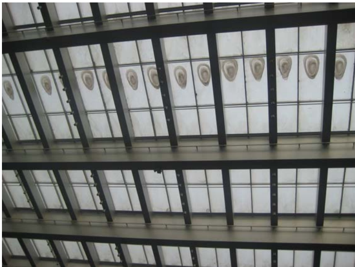
Bild 7: Dachkonstruktion (Foto: Juliane Hermle)
