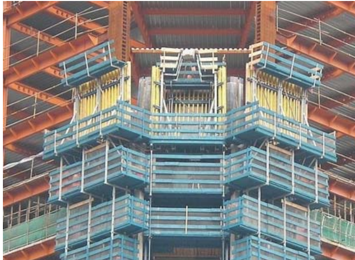
Bild 8: Schalung SKE 50 / TOP 50 [2]
