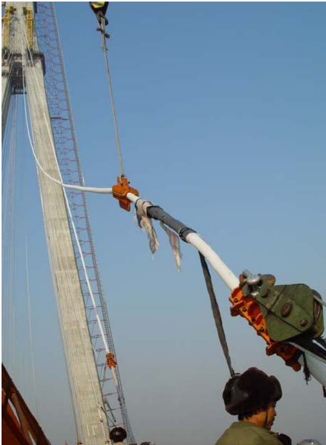
Bild 13: Einbau des zehnten, 228m langen Seils [7]
