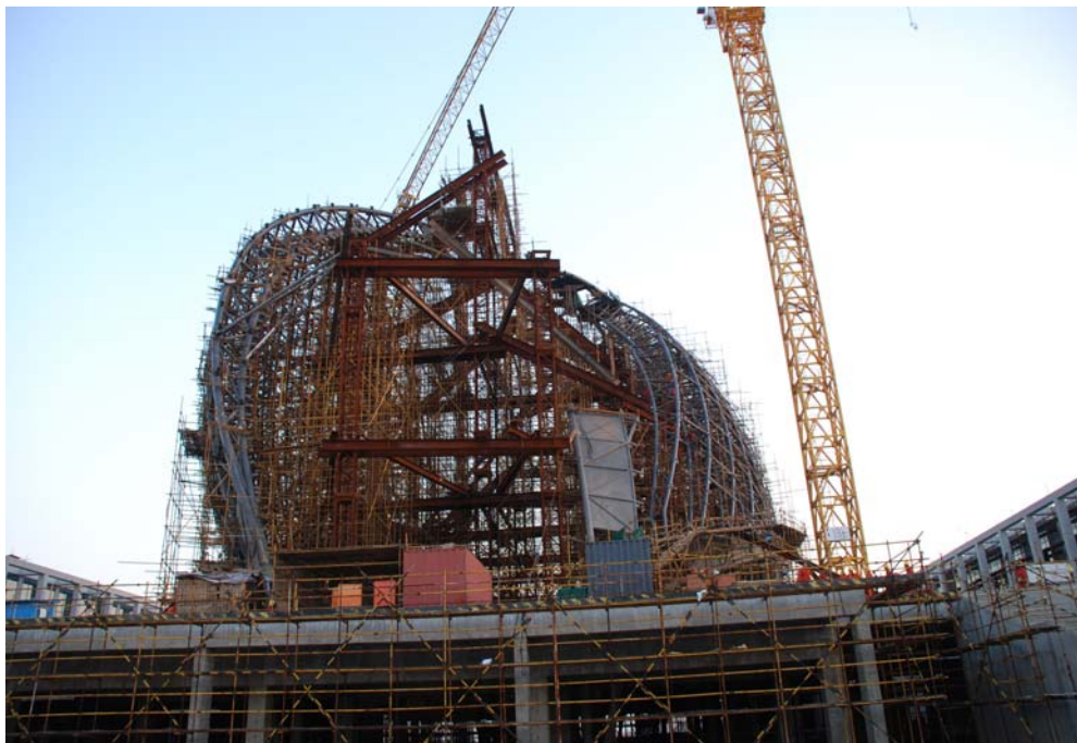
Bild 13: Segel (Dachschalen) des Maritime Museums im Bauzustand (Foto: Dominik Mölder)
