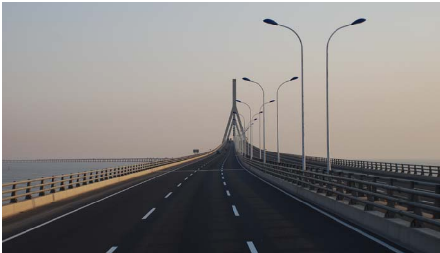
Bild 18: Auf der Donghai Brücke (Foto: Philip Scherzinger)
