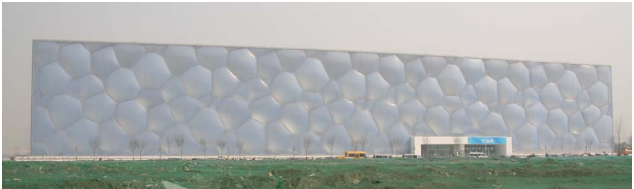
Bild 4: Nationales Wassersportzentrum (Foto: Horst Werkle)
