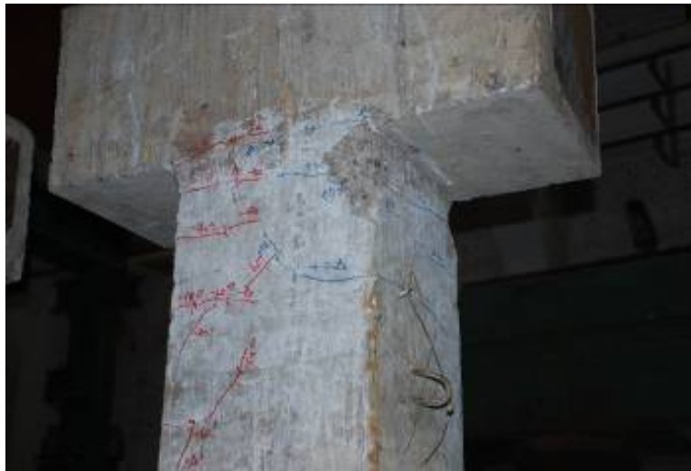
Bild 4: Stützenverstärkung mit Kohlefasergewebe (Foto: Philip Scherzinger)
