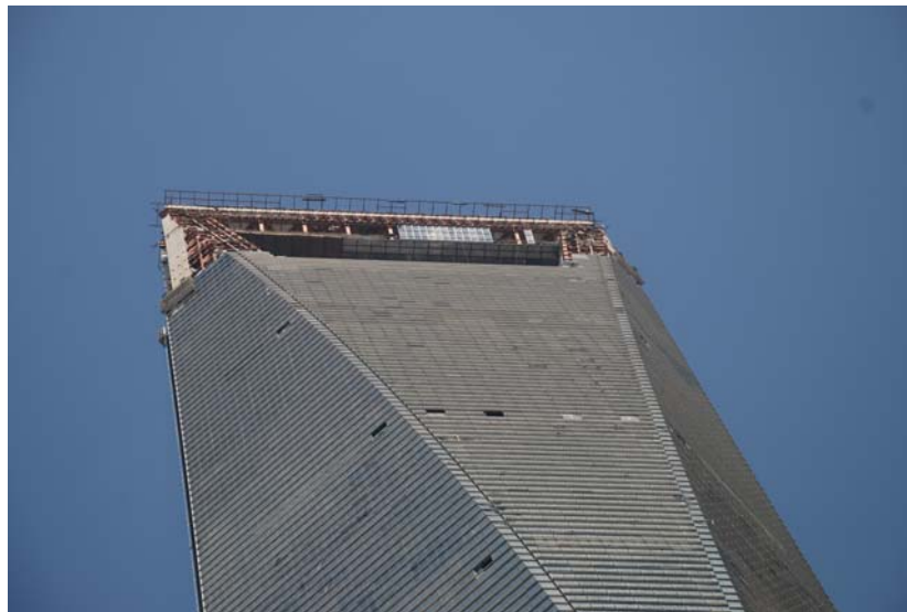
Bild 4: Fassadenbau an der Spitze des WFC (Foto: Horst Werkle)
