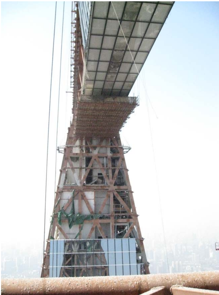
Bild 6: Stahlkonstruktion über der Aussichtsplattform (Foto: Horst Werkle)
