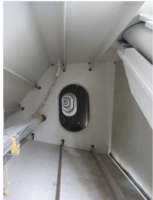
Bild 14: Im Inneren des Überbaus, (Foto: Andreas Niederer)
