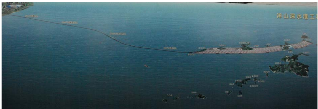
Bild 14: Gesamtübersicht der Brücke (Foto: Philip Scherzinger)
