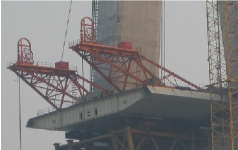
Bild 10: Orthotrope Fahrbahnplatte mit Hydraulikkran [6]
