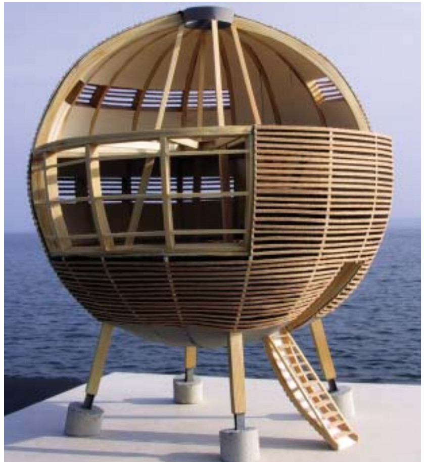
Abb. 8: Aufgeschnittene Seite: Innenraum und die einzelnen Hauptelemente
