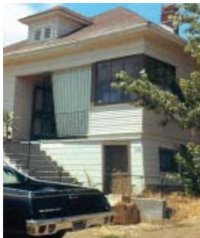
Abb. 1: Einfamilienhaus auf der Hayward-Verwerfung in Kalifornien
