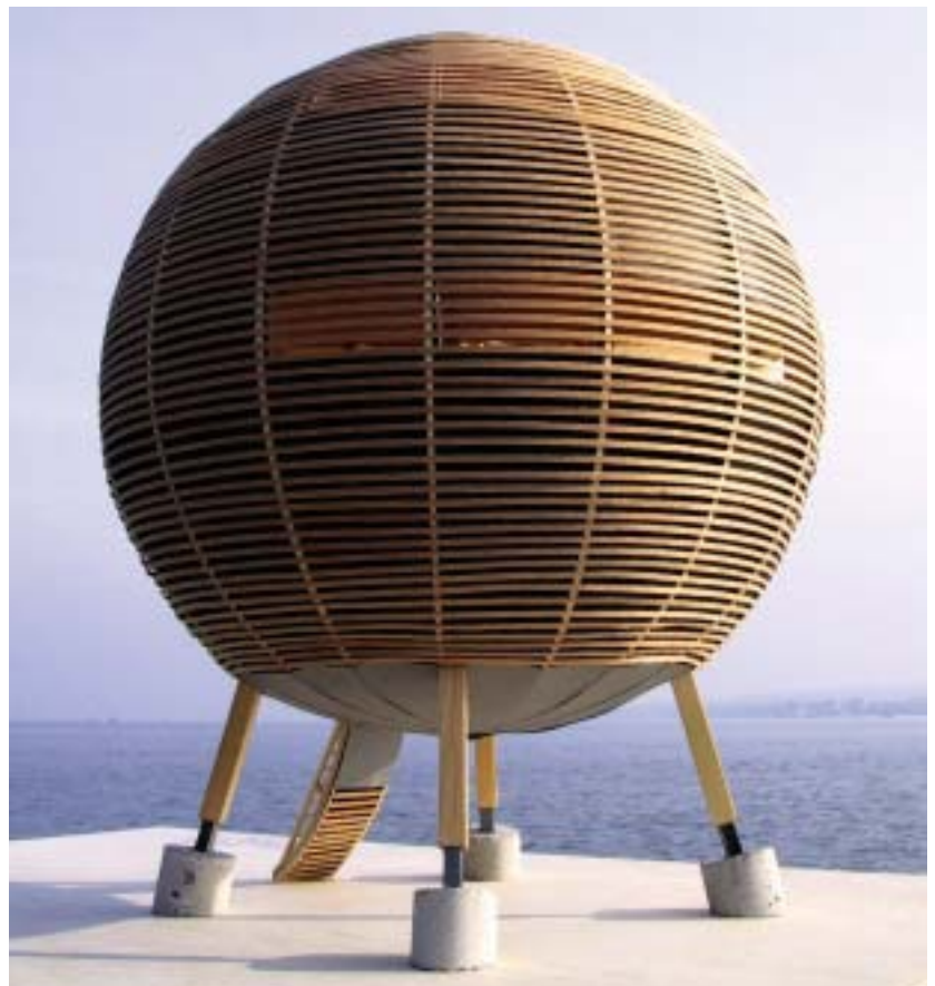
Abb. 1: Modell des Kugelhauses: Gut zu erkennen ist die Außenfassade mit den umlaufenden Lärchenlamellen
