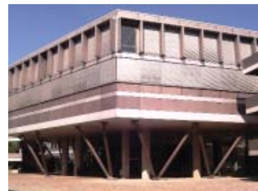
Abb. 9: Erdbebensanierungsmaßnahmen an einem Hörsaalgebäude der ETH Zürich
