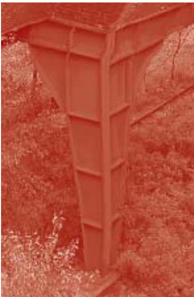
Abb. 15: Der untere Rahmenteil des Eckturms [Archiv Dicleli]
