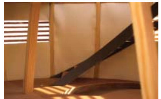
Abb. 6: Blick vom Ausschnitt ins Rauminnere des EG; Treppe ins OG; die Beplankung wird über die Fenster geführt und sorgt somit für ein harmonisches Licht
