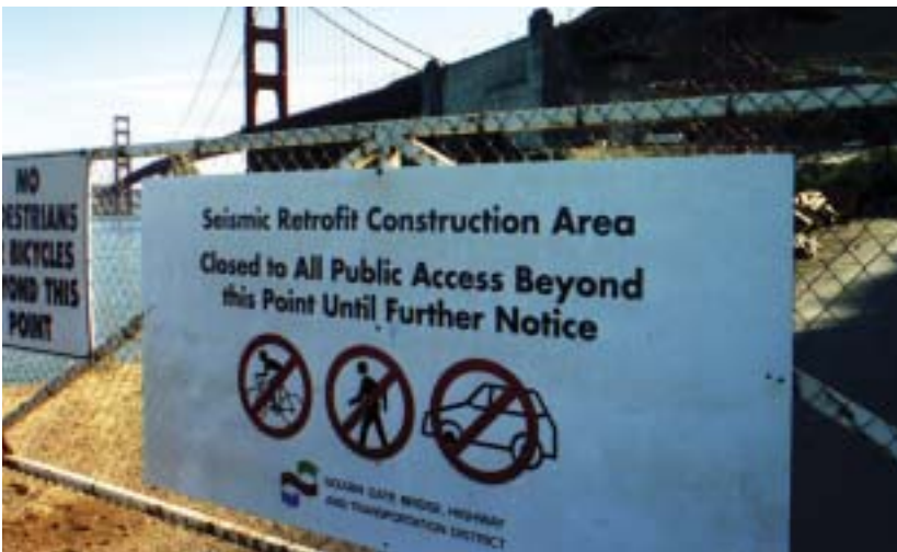
Abb. 10: Erdbebensanierungsmaßnahmen an der Golden-Gate-Bridge
