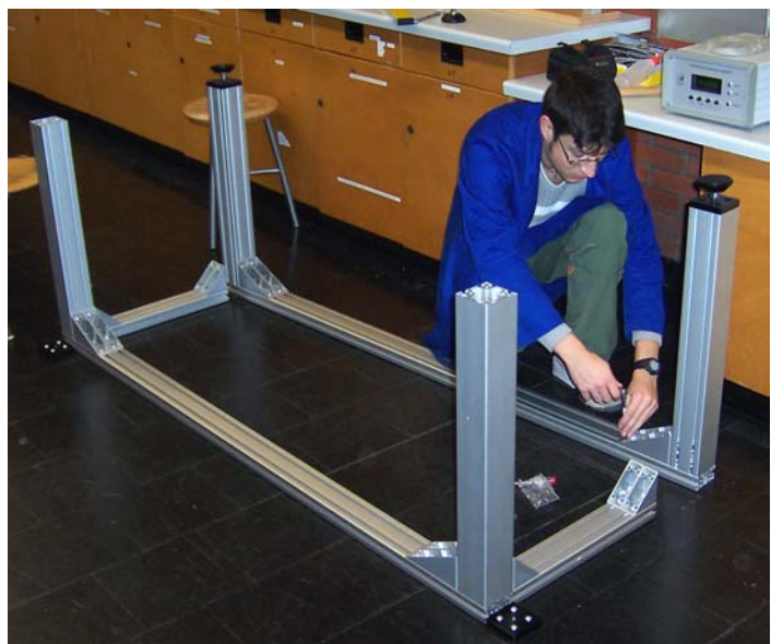
Abb.5.10 Montage des Alu-Gerüsts
