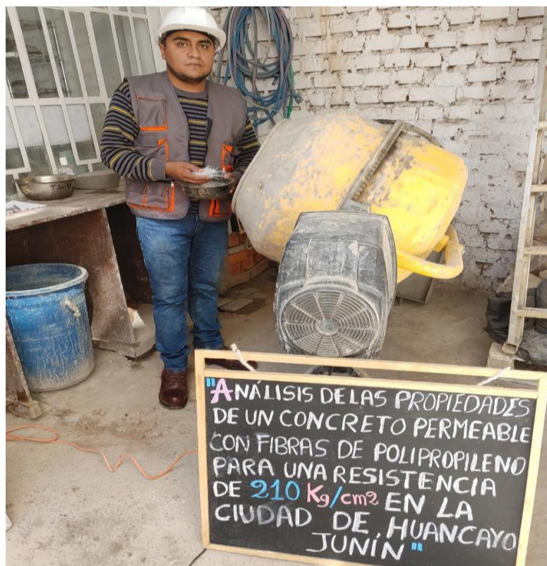
Figura N° 16: Preparación del concreto permeable adicionado las fibras de polipropileno
