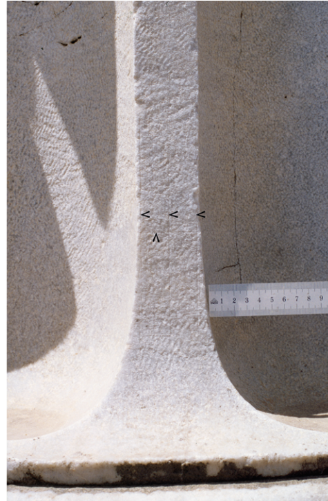
Abb. 16: Didyma, Apollontempel, Säulenfuß mit Ritzmarkierungen (Pfeile) und proportionalen Hauptmaßen. Unterer Schaftdurchmesser und Plinthenlänge wurden in das klare Zahlenverhältnis 3 : 4 gesetzt (unten, M. 1 : 40). Diese beiden Hauptgrößen artikulieren die Gelenkstelle zwischen »Fußspur« und Aufriss der Säule. Der Gesamtausladung der Plinthe ( 2 \times 1 \frac{1}{2} Fuß) kommt dabei der Zahlenwert 1 zu.
