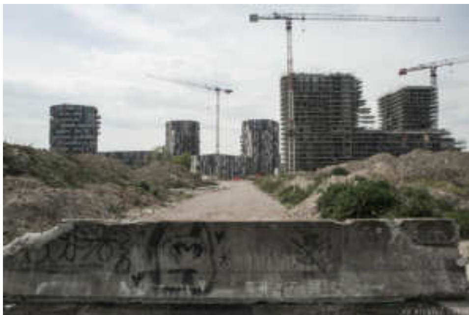
Fig. 8. Il cantiere di piazza Liber Paradisus.
