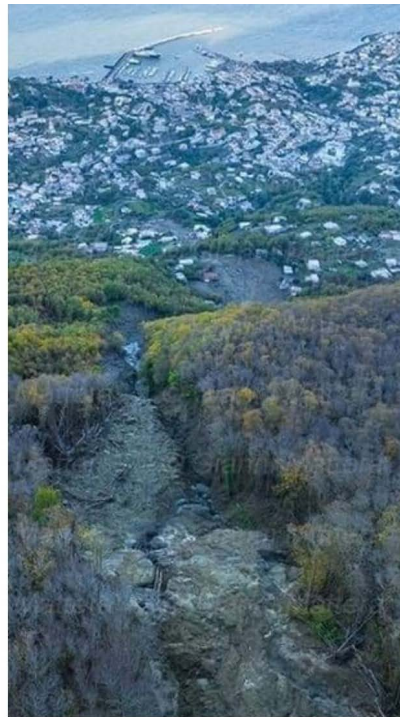
A sinistra: lavori di regimentazione delle acque dopo l'alluvione del 1910. A destra: il percorso della frana del 2022 dal Monte Epomeo al porto di Casamicciola (tagliare la parte in alto)
