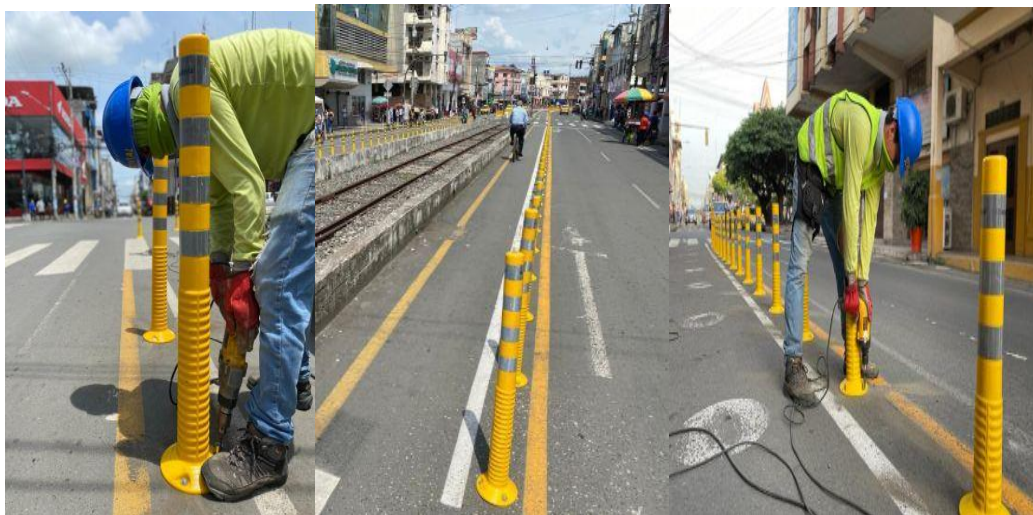
Figura 14-3 Colocación de barrera de protección en la ciclovía en la calle Pedro Carbo, entre las av. García Moreno y Juan Montalvo Fuente: EMOVIM
