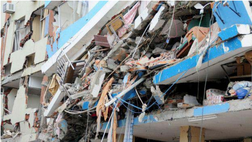
Imagen 1. Edificio destruido en el terremoto de Ecuador-Abril 2016
