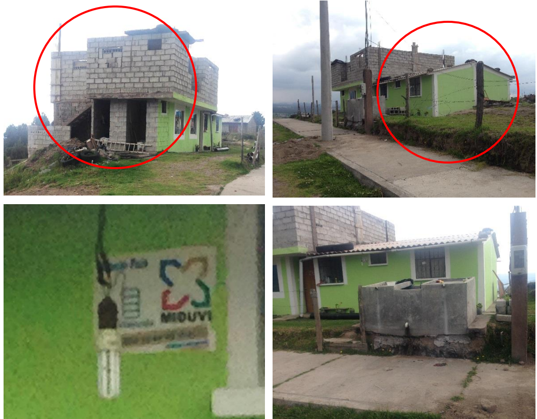
Imagen N.- 106 Vivienda tipo construida con ayuda del Estado: Ampliación empírica variable
