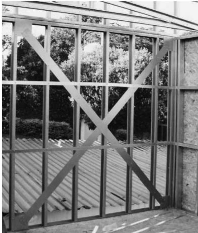
Imagen N.- 82 Panel con Cruces de San Andrés o diafragmas rigidizador, Steel Frame
