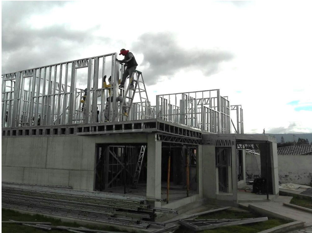
Imagen N.- 87 Sistema constructivo, Steel Frame
