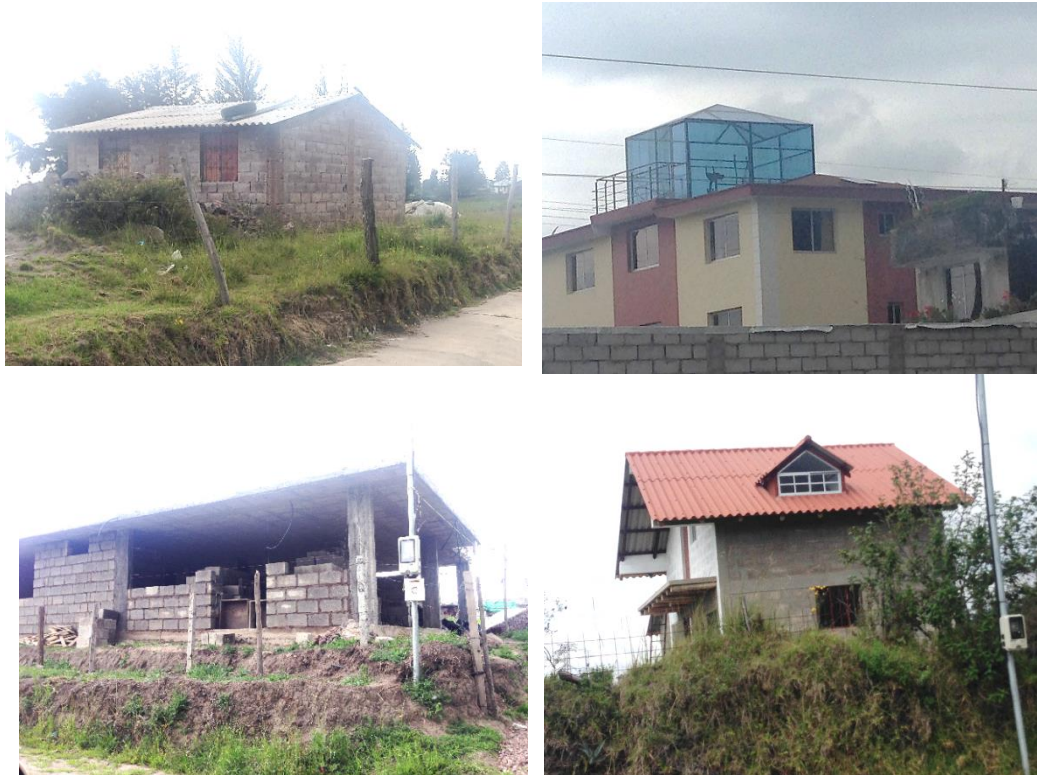
Imagen N.- 105 Viviendas en diferentes alturas con sistemas constructivos mixtos y hormigón armado
