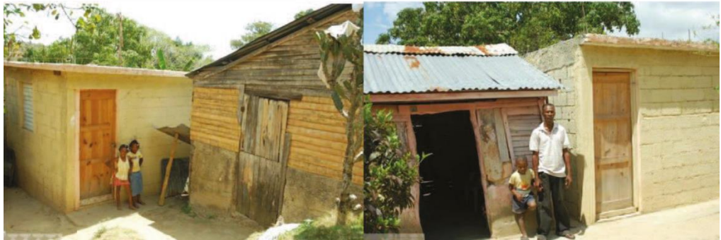
Imagen N.- 34 Habitación refugio
