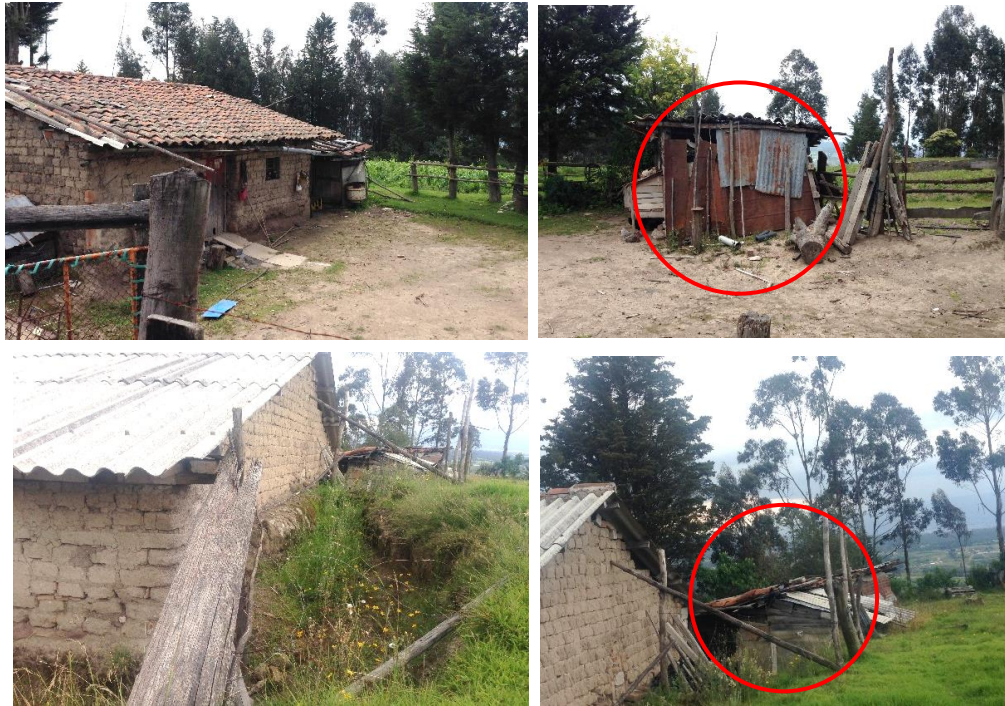
Imagen N.- 104 Viviendas de sistema constructivo con adobe y bareque con servicio higiénico en el exterior
