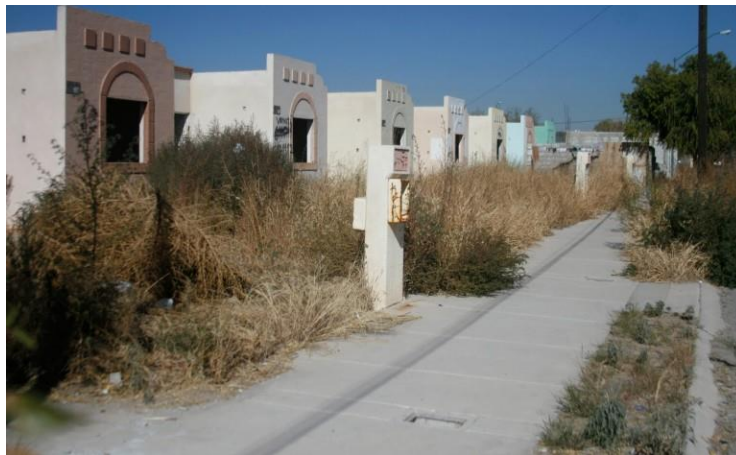
Imagen N.- 33 Casas en deterioro y abandonadas
