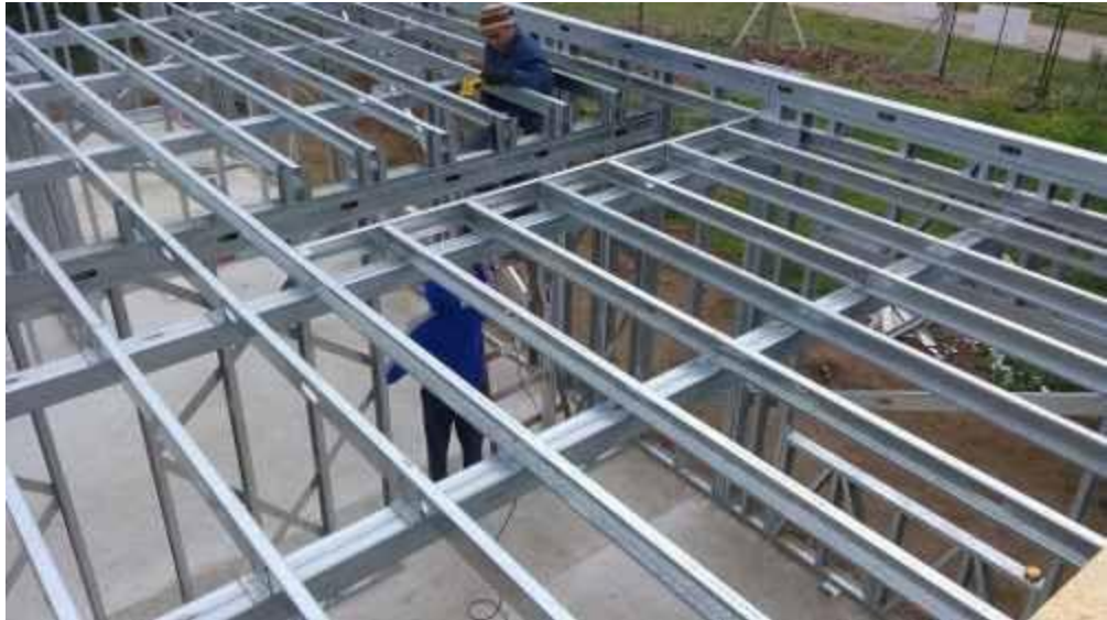
Imagen N.- 86 Vigas de entrepiso, Steel Frame
