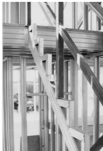
Imagen N.- 94 Detalle escalera viga cajon inclinada, Steel Frame
