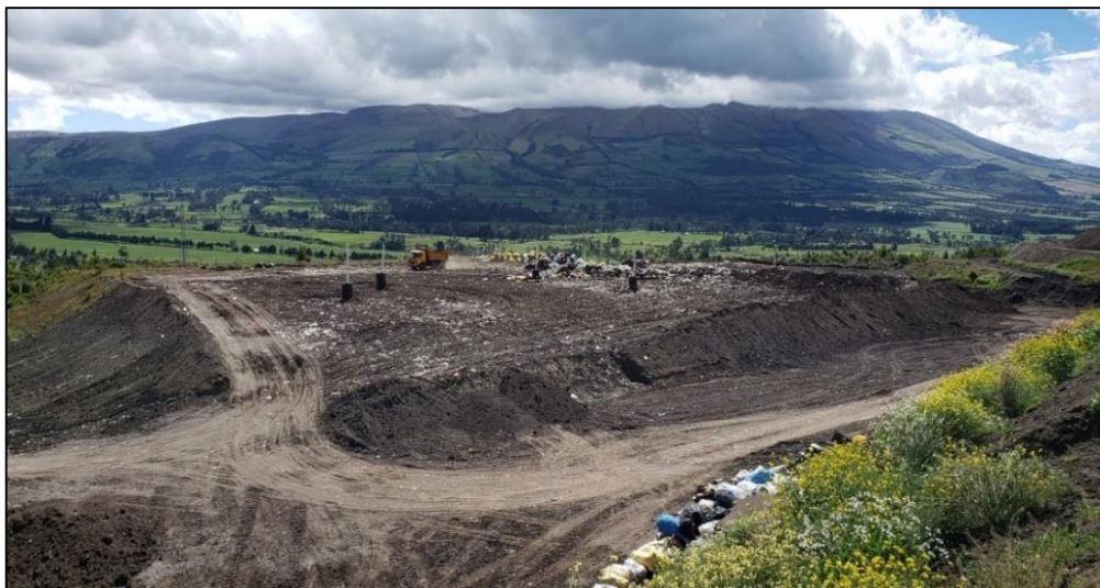
Fotografía N° 23. Operación del Relleno Sanitario
