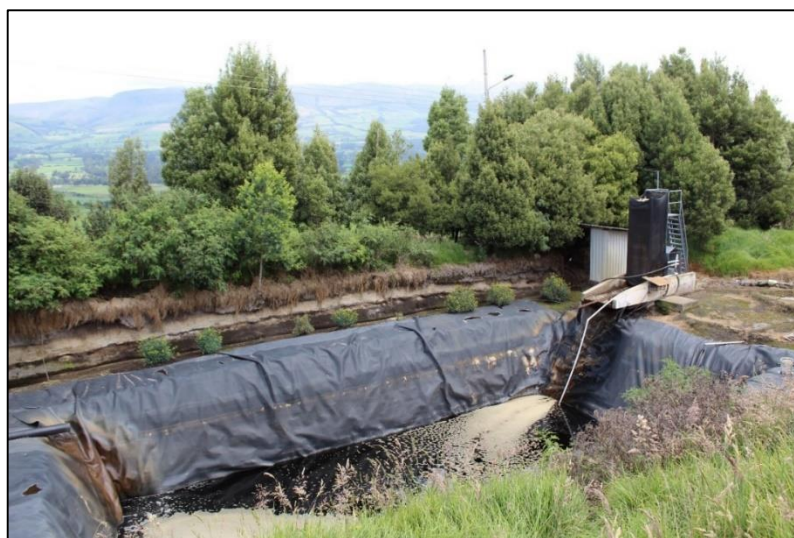
Fotografía N° 24. Piscina de descarga de lixiviados
