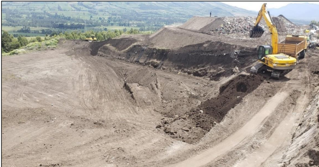
Fotografía N° 21. Taludes de Estabilización
