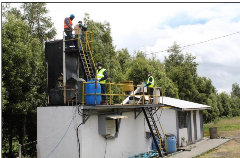
Fotografía N° 25. Planta de Tratamiento de Lixiviados
