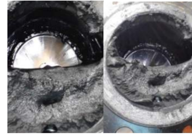
Figura 5. Polímero gelificado en tuberías.
