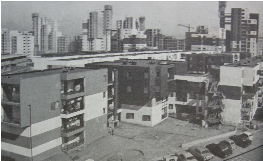
Gráfico N° 14: Estudio Staff-Conjunto Villa Sodati, Buenos Aires (1973-1977) Fuente: Adaptado de Montaner, J. (2015) “La arquitectura de la vivienda colectiva”
