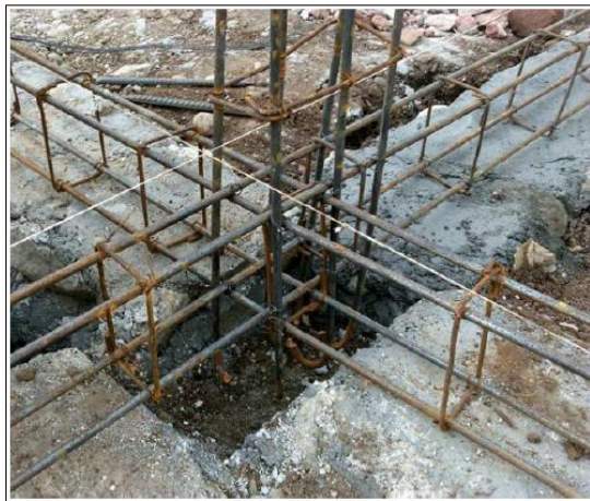
Gambar 2. Bentuk begel terpasang pada kolom
