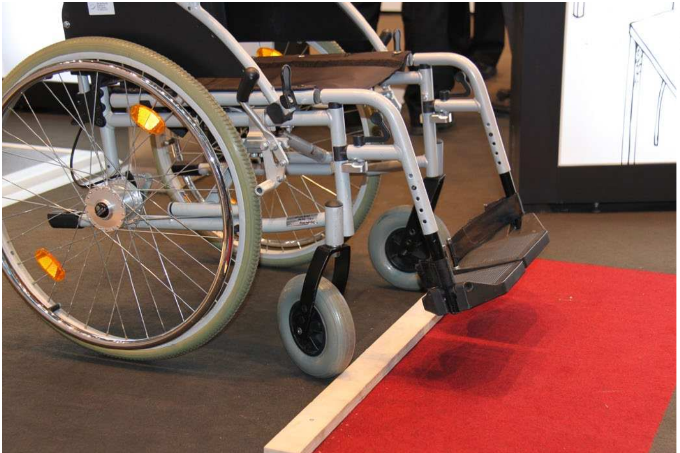
No Go für Barrierefreiheit: Eckige Türschwellen sind Stolperfallen und benötigen hohen Kraftaufwand, um sie mit Rollen zu überwinden.
