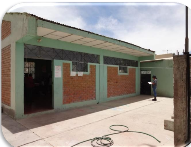
Foto nº 10: ingreso y ambiente adjunto al ambiente de intervención, paredes de albañilería con columnas y vigas de amarre de concreto armado
