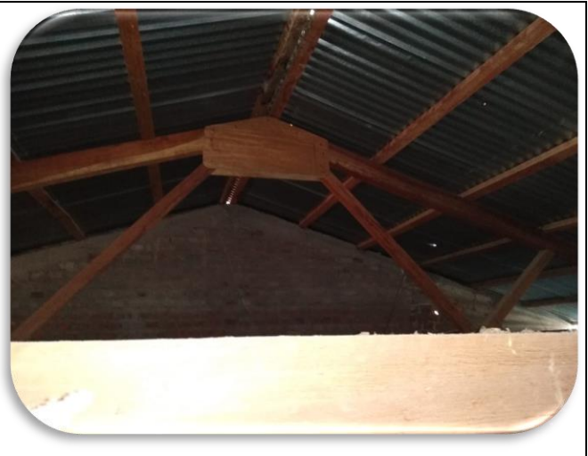
Foto nº 02 interior de estructura, se observa la parte superior
