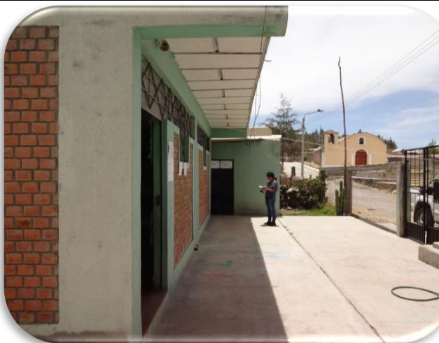
Foto nº 09: exterior de ambiente, puerta de ingreso, cobertura exterior de ambiente, donde se colocará una precámara
