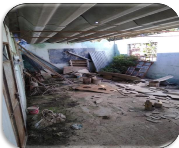
Foto nº 10: ingreso y ambiente adjunto al ambiente de intervención, paredes de albañilería con columnas y vigas de amarre de concreto armado
